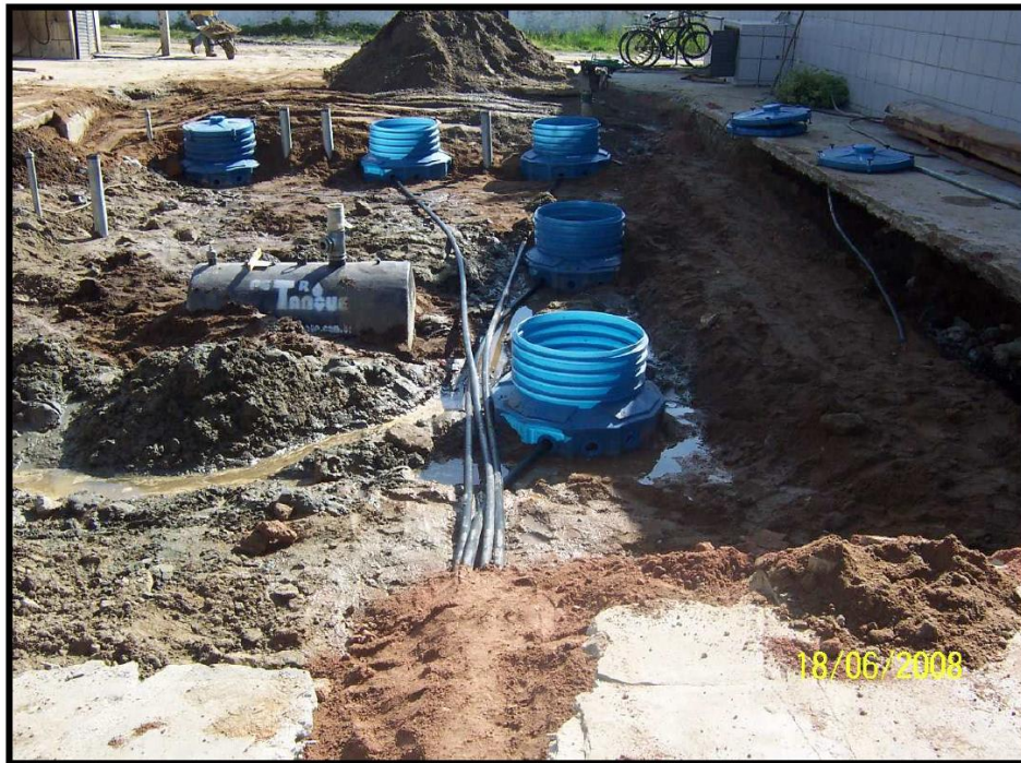
Figura 26: Instalação de tanques ecológicos na Área 5.
