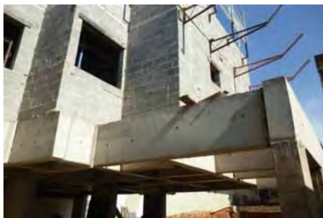
Figura 43– Estrutura de transição
