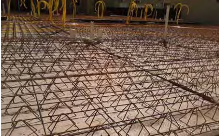
Figura 66 – Execução de radier
