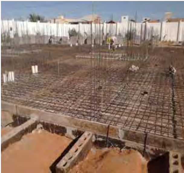
Figura 56 – Armação do radier
