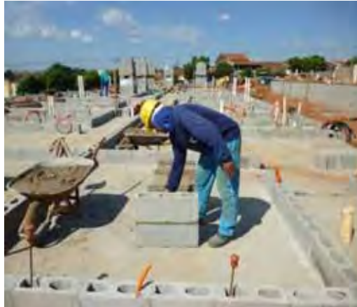
Figura 72 – Preparação de prismas
