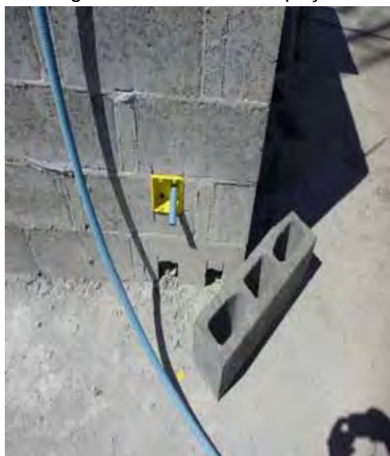
Figura 91– Ponto de inspeção
