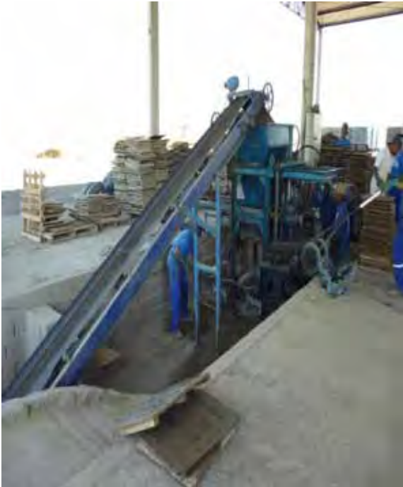
Figura 9 – Transporte do concreto
