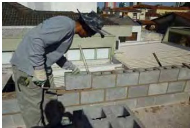
Figura 40- Assentamento de blocos
