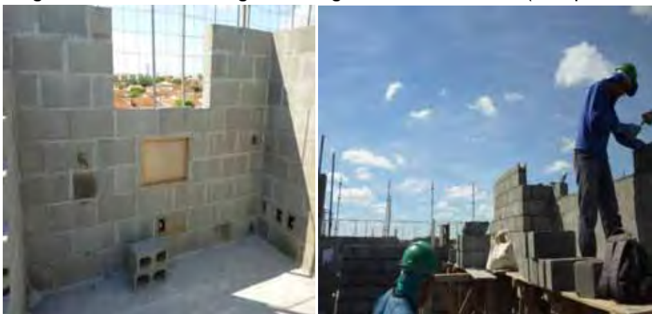
Figura 69 – Pontos de graute Figura 70 – Canaleta (compensador)
