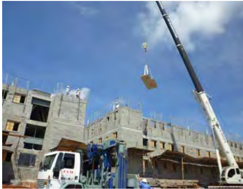
Figura 75- Montagem das lajes
