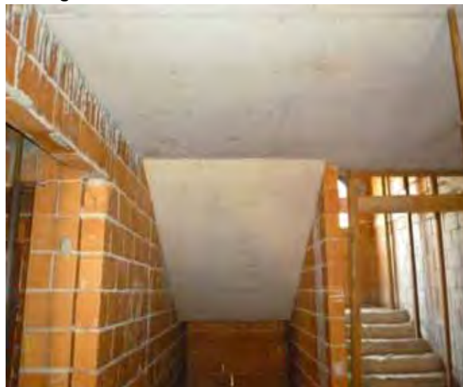
Figura 83- Escada em concreto armado
