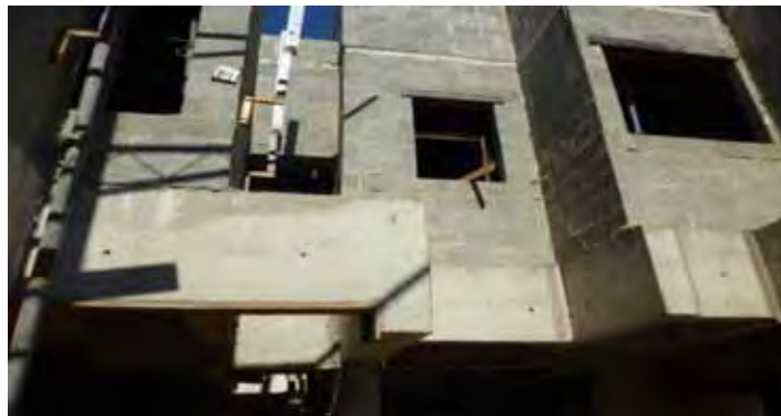
Figura 42- Estrutura de transição
