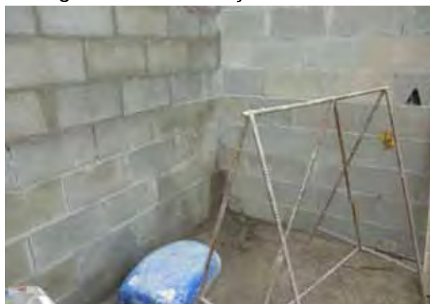
Figura 38 – Modulação da alvenaria
