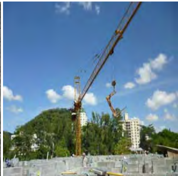
Figura 88 – Movimentação dos blocos
