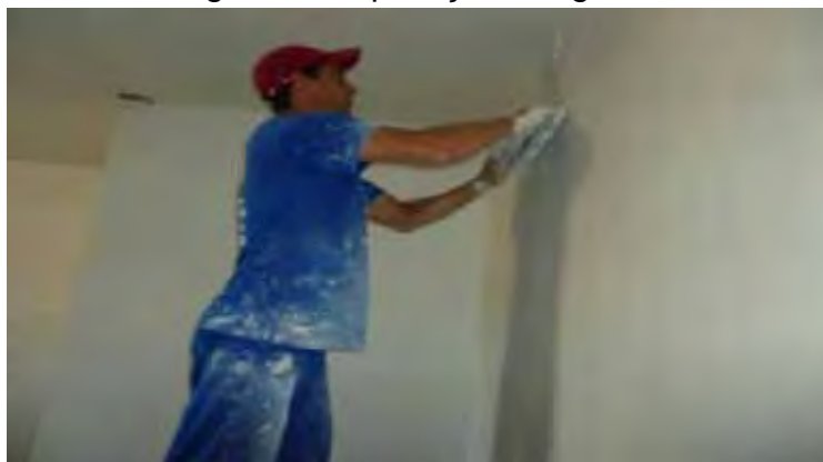
Figura 77- Aplicação de gesso
