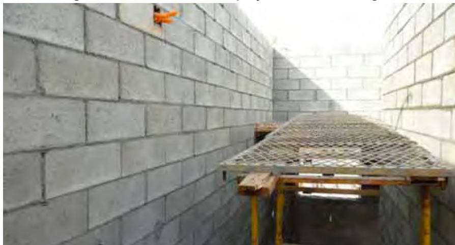
Figura 48 – Ponto de inspeção de concretagem
