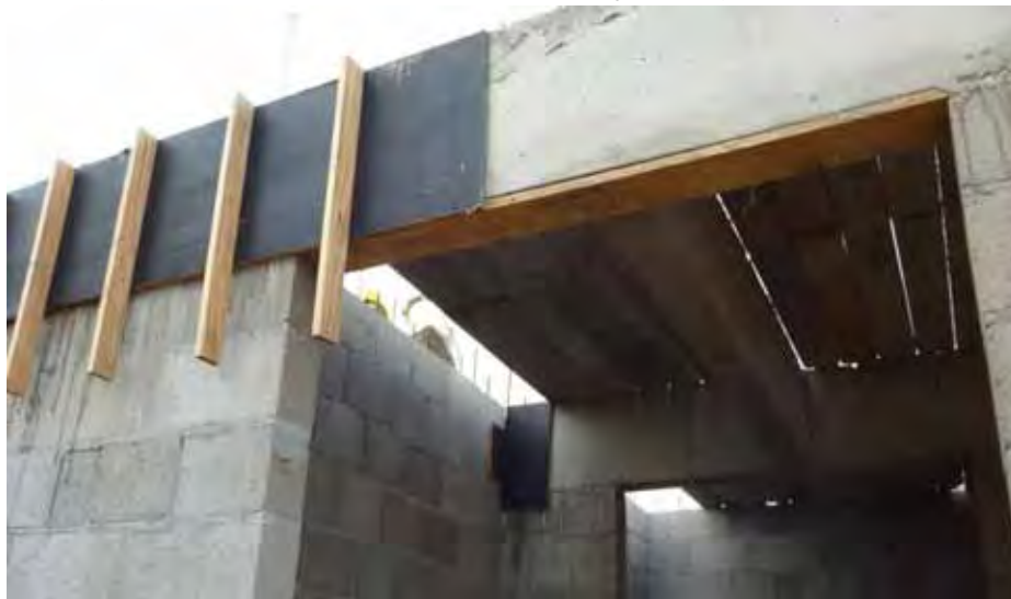
Figura 61 - Laje pré-moldada (maciça) / vigas de concreto
