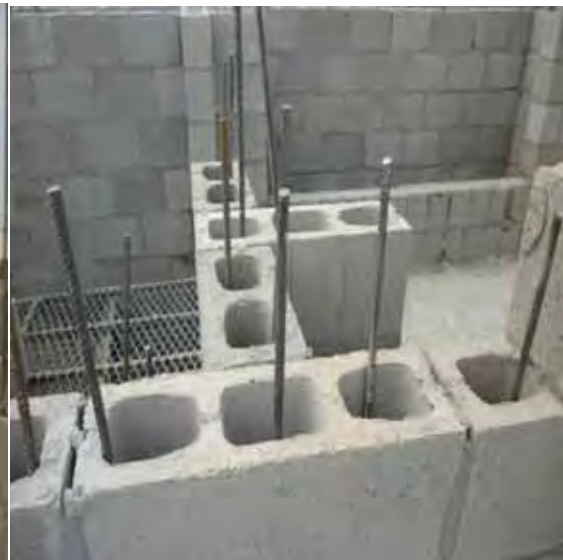
Figura 59 – Armadura (à grautear)
