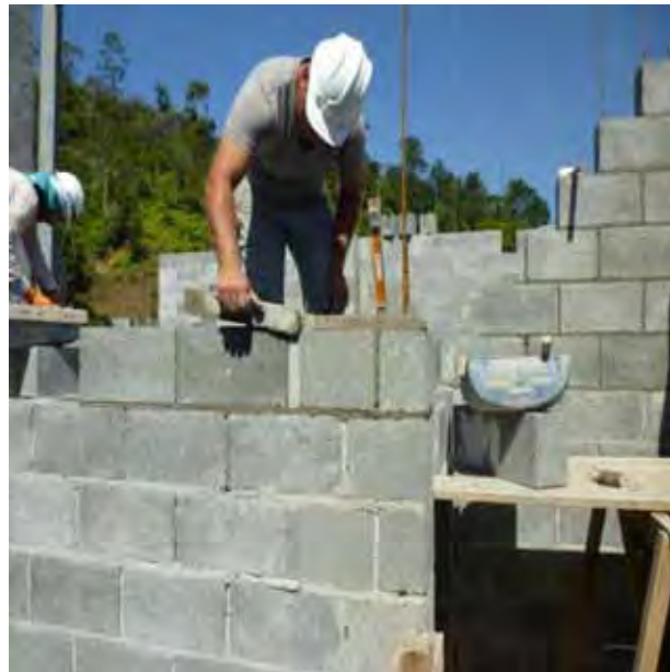
Figura 115- Assentamento de blocos
