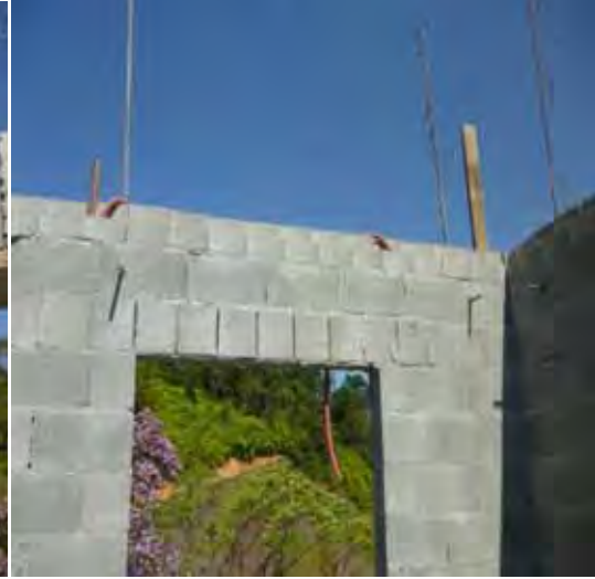
Figura 117 – Detalhe (bloco “J”)
