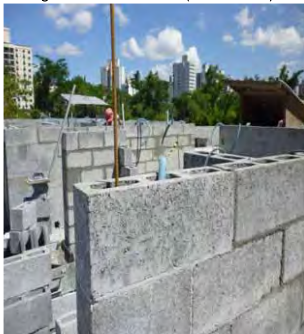
Figura 92– Armadura (meia altura)
