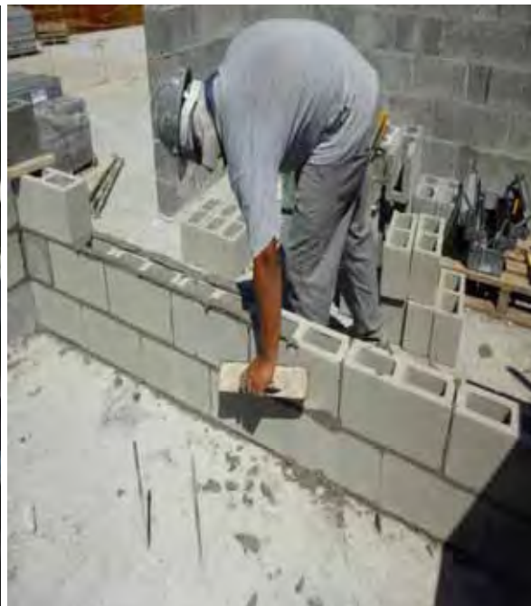
Figura 90 - Assentamento de blocos
