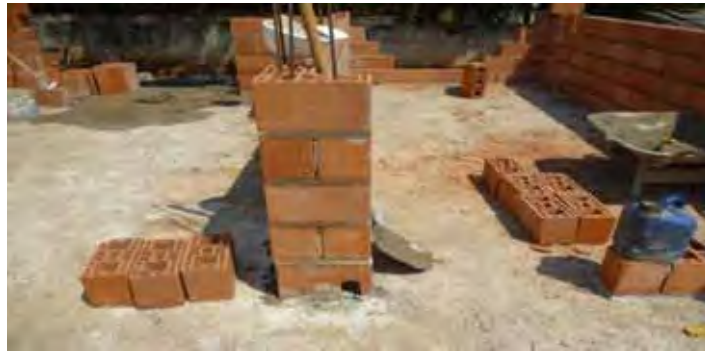
Figura 80- Pontos de grauteamento
