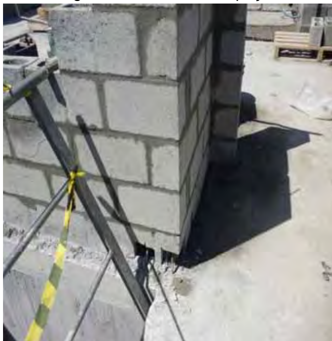
Figura 93 – Ponto de inspeção
