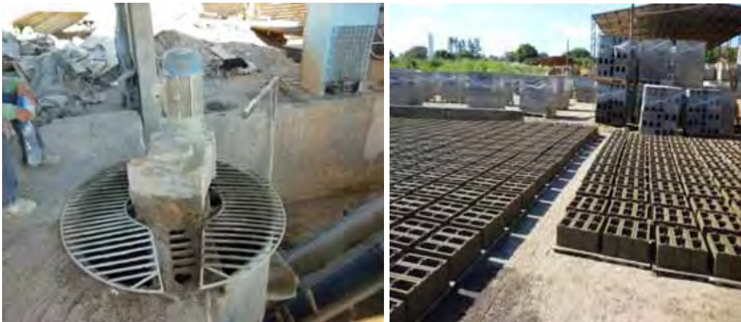
Figura 28 – Dosagem do concreto / cura dos blocos
