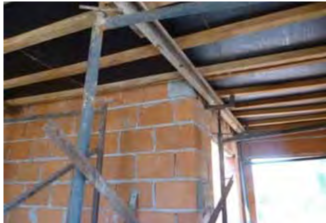
Figura 82 – Laje maciça (forma/escoramento)
