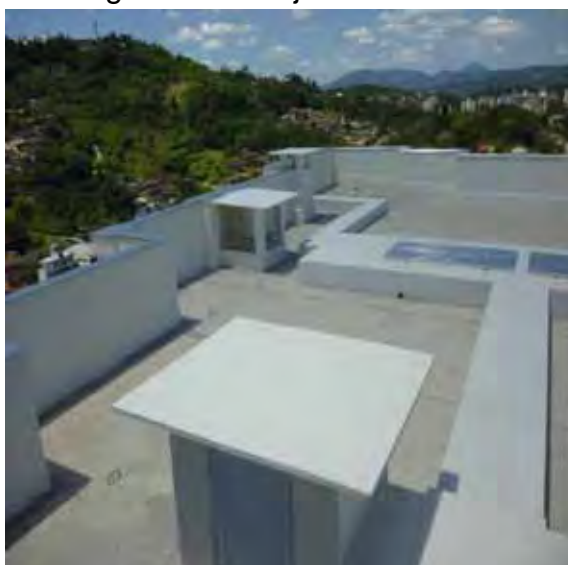
Figura 100– Laje de cobertura
