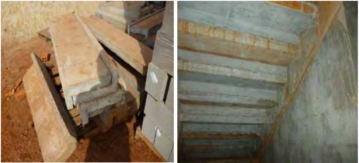
Figura 52- peças pré- moldadas para a escada
