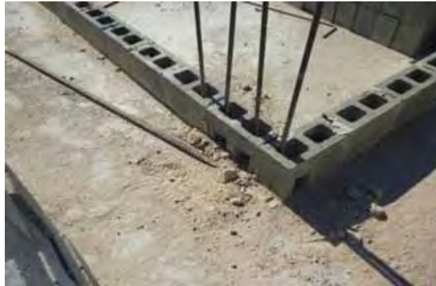
Figura 41 – Pontos de grauteamento
