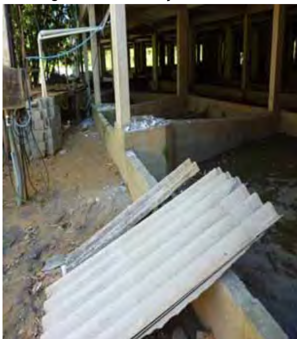
Figura 94– Fundações e estrutura
