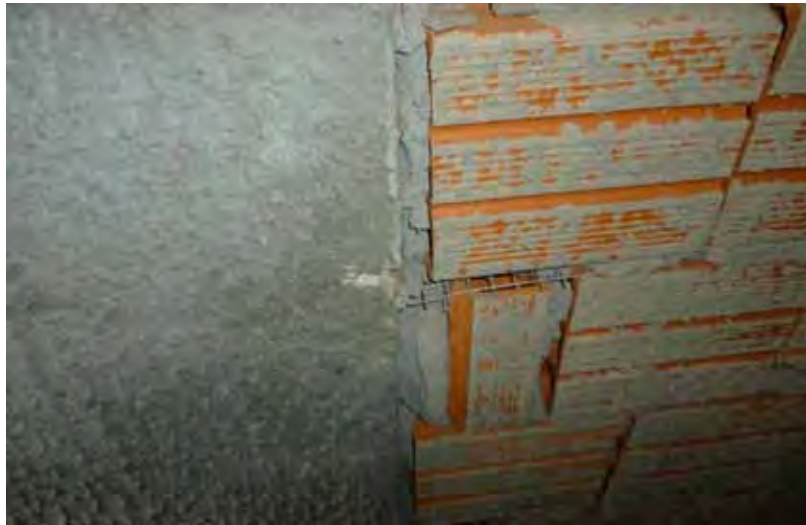
Figura 50– Armaduras construtiva
