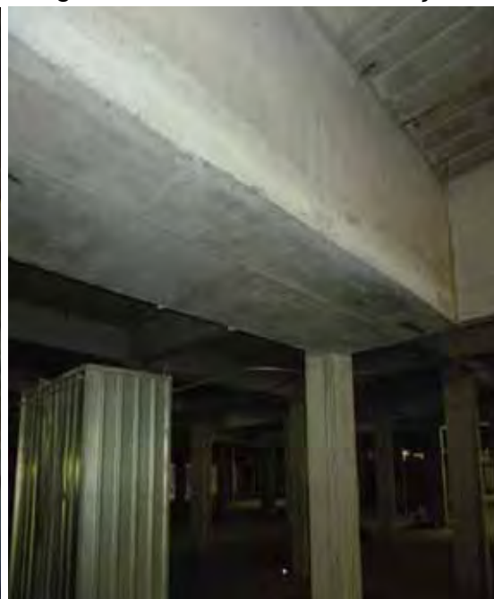
Figura 95 – Estrutura de transição
