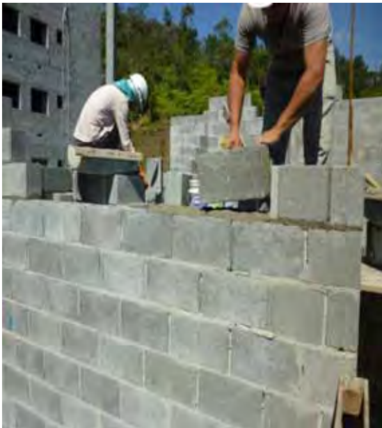
Figura 114 – Assentamento de blocos
