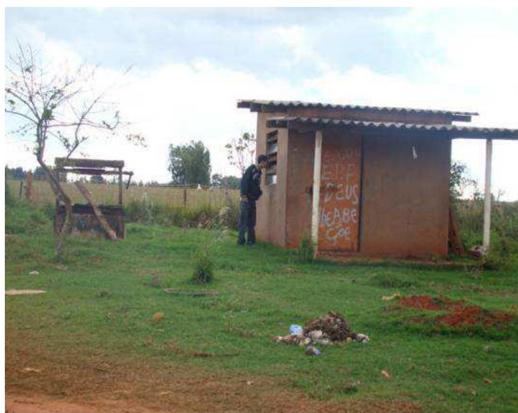
Figura 18 - Entrada com guarita no aterro em vala
