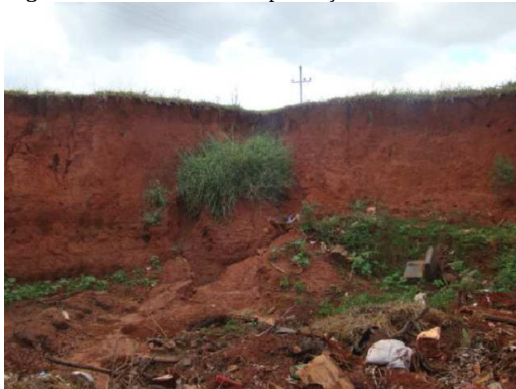
Figura 19 - Área aberta com presença de resíduos sólidos
