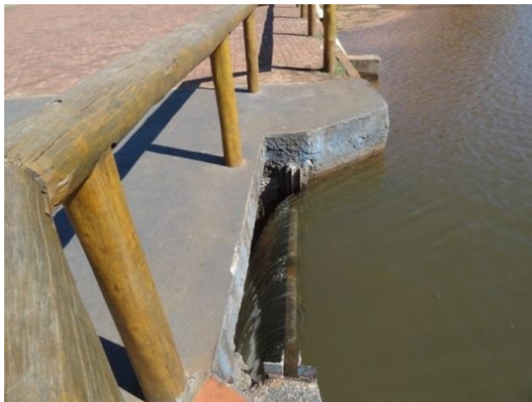
Figura 30 - Canalização do curso d'água em trecho do Balneário
