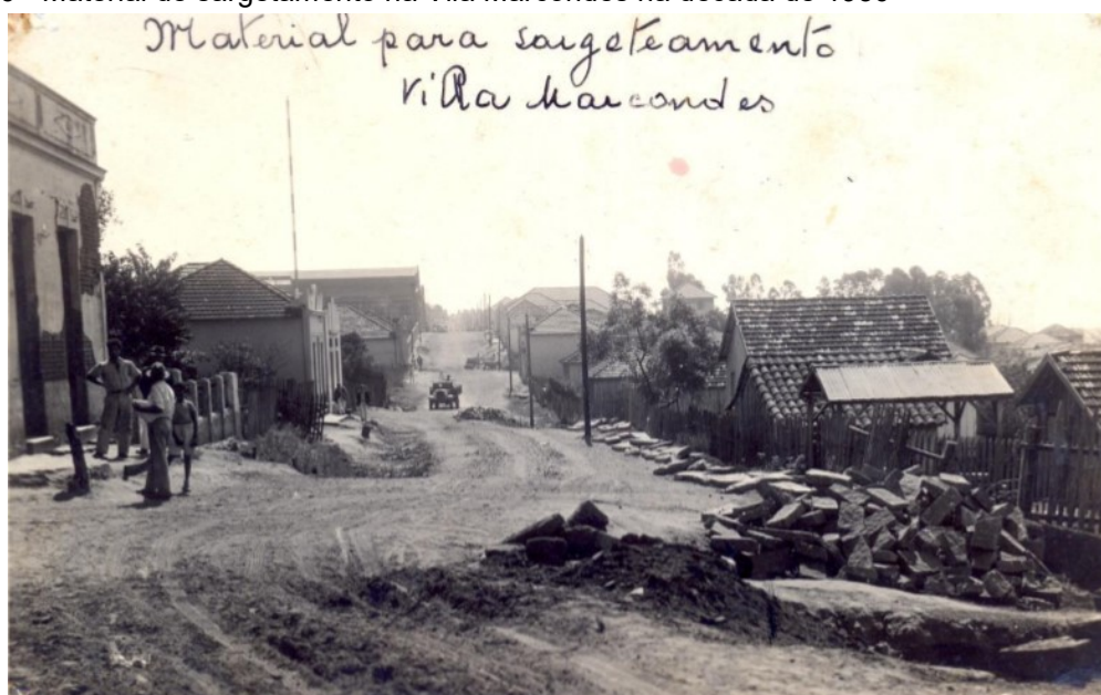
Figura 56 - Material de sargetamento na Vila Marcondes na década de 1930
