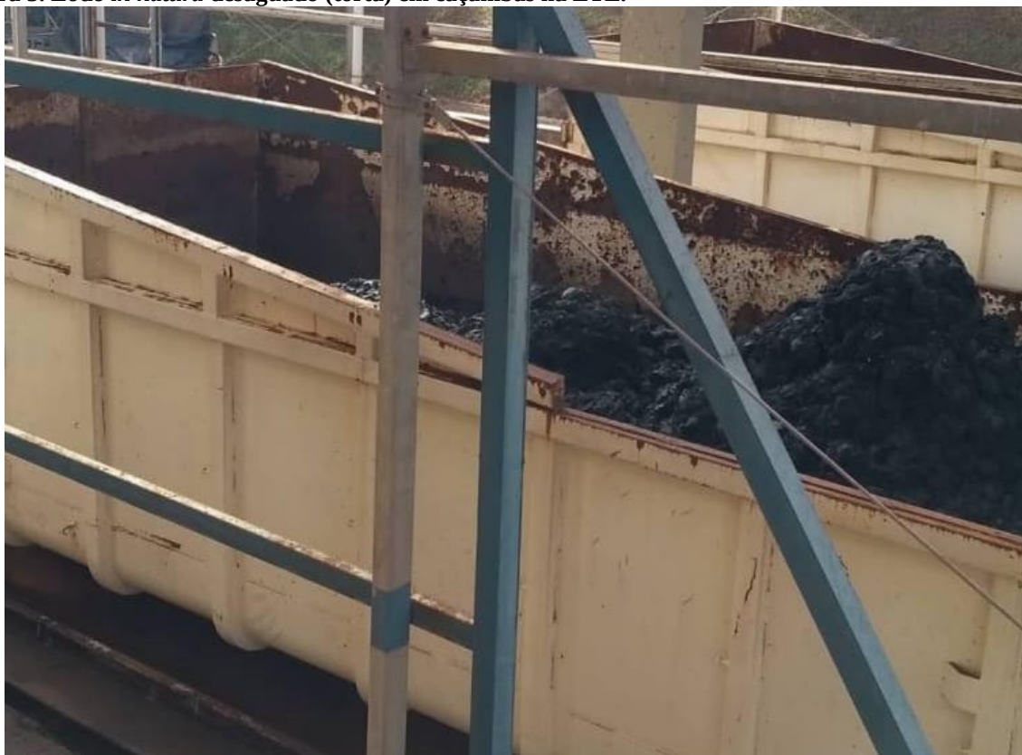
Figura 3. Lodo in natura desaguado (torta) em caçambas na ETE.
