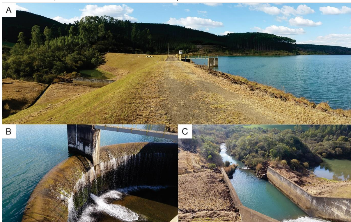
Figura 2 - Barragem Águas Claras em detalhe: A – Visão panorâmica pela crista da barragem. À direita, talude montante, com enrocamento ( rip-rap ), lago do reservatório e vertedouro em evidência. À esquerda, talude de jusante, com proteção vegetal, bacia de dissipação e área alagada; B – Vertedouro em arco de simples curvatura; D - Canal de restituição do sistema extravasor.
