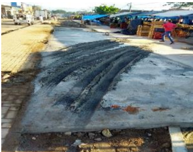
Imagem 3: Marcas de roda em um trecho de calçada executado
