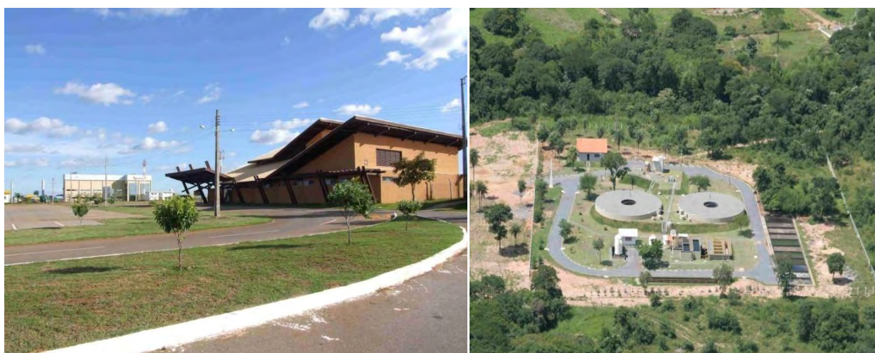
Figura 6: Aeroporto e Estação de Tratamento de Esgoto
