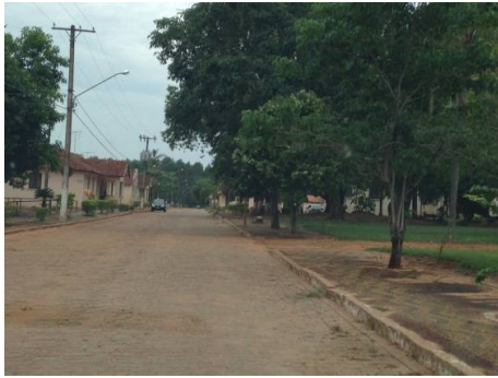
Figura 77 – Imagem do trecho 12a mostrando ausência de piso tátil
