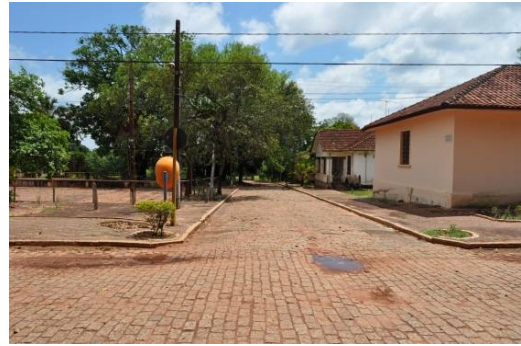
Figura 68 - Imagem do trecho 13d mostrando a inexistência de grelhas
