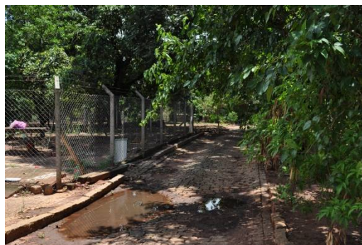
Figura 52 – Imagem do trecho 12b mostrando a calçada com largura inferior a 1,20m
