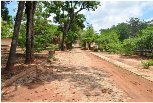
Figura 67 – Imagem do trecho 8c mostrando a inexistência de grelhas
