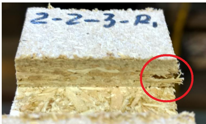
Figura 59 - Detalhe com arranque de material na lateral do painel de MDP
