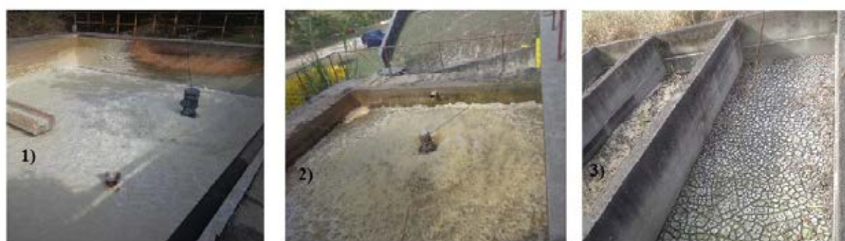
Figura 5 - Processo de tratamento de efluentes industriais da SERRAMAR. 1) Reator aeróbico; 2) Digestor de lodo aeróbico e 3) Leitos de Secagem.
