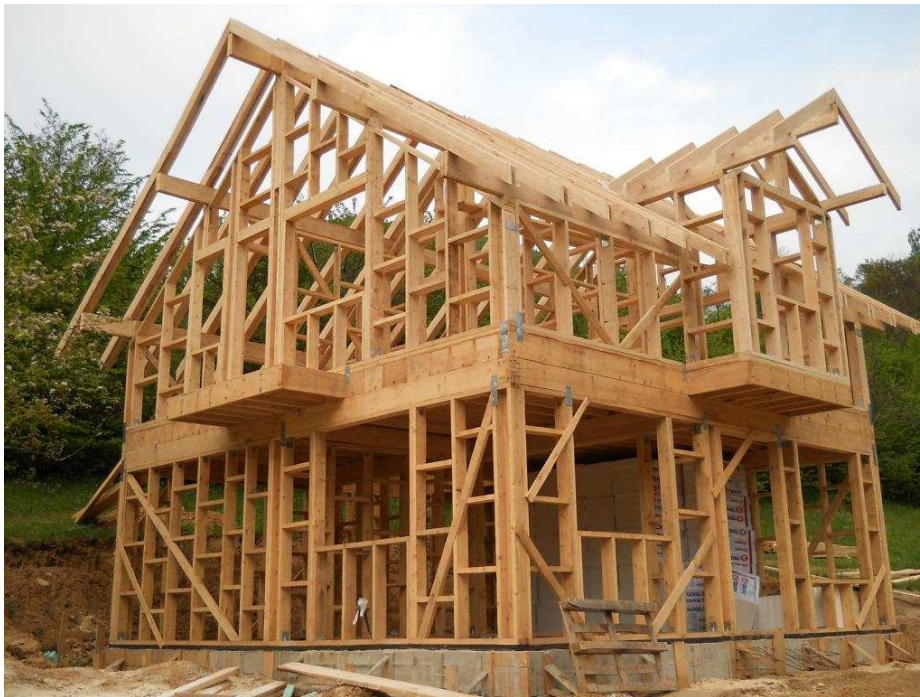
Figura 4 – Construção em Wood Frame
