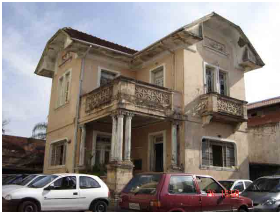
Foto 9: Casa da Rua Dom Pedro n. 87 em Marília. (Foto: Rodrigo Modesto Nascimento, 2005).
