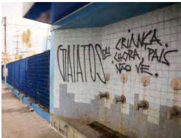
Figura 17C – Escola Municipal Alcina Dantes Feijão em São Caetano do Sul (SP).
