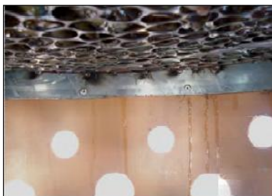
Figura 9. Foto da chapa de aço inox para apoio do meio suporte.
