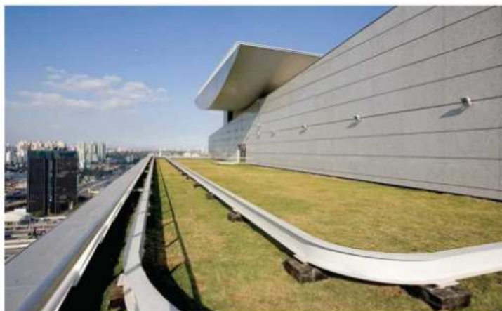
Figura 8 - Captação de água pluviais
