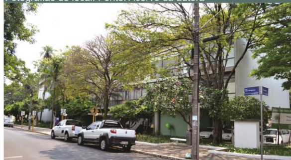
Praça das Cerejeiras e prédio da Prefeitura Municipal de Bauru
