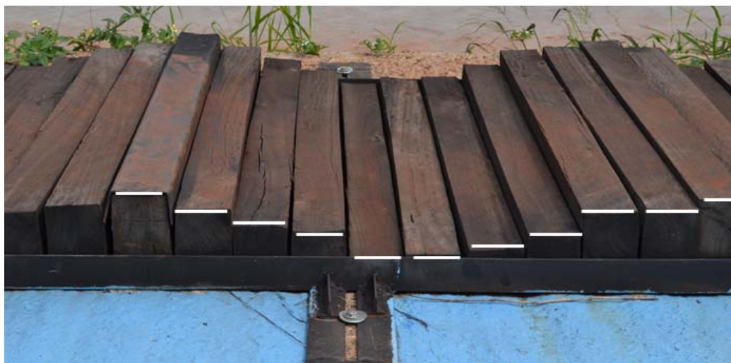
Figura 7: Degraus com diferentes alturas ao longo da pista.
