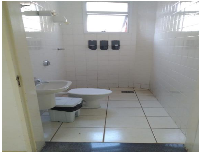
Figura 15: Banheiro para uso dos internos.
