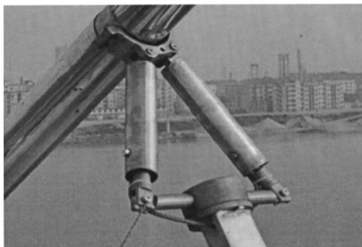
Figura 2 – controle semi-ativo de vibração de cabos estaiados utilizando amortecedores MR.
