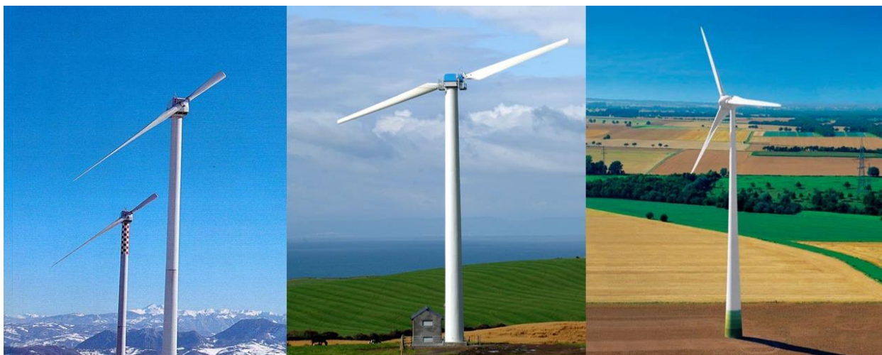
Figura 2.2. HAWT de uma pá, de duas pás e de três pás
