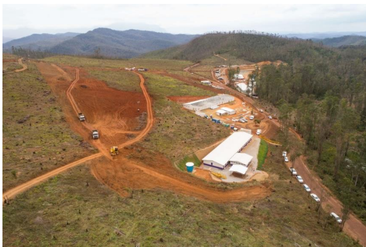
Figura 52 – Construção do Novo Bento Rodrigues
