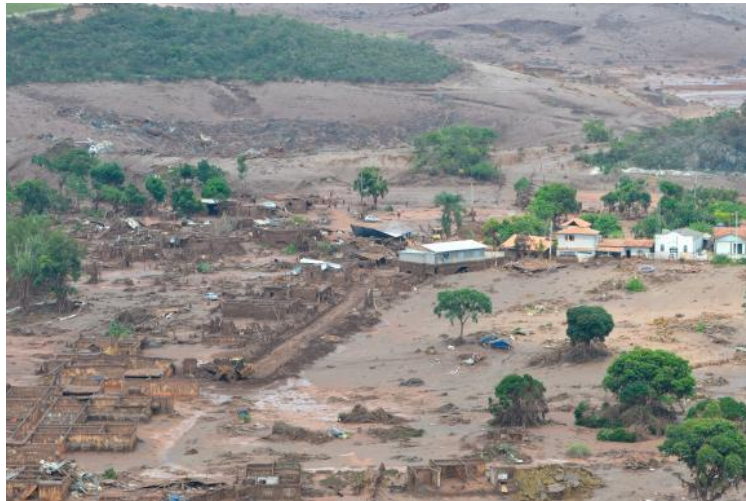
Figura 28 – Destruição de Bento Rodrigues
