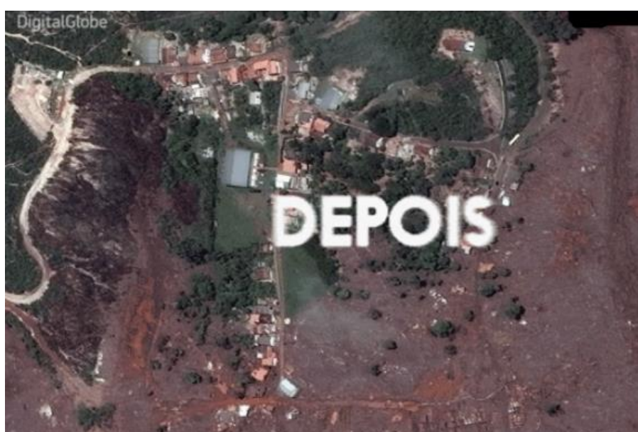
Figura 27 – Bento Rodrigues após o rompimento da barragem
