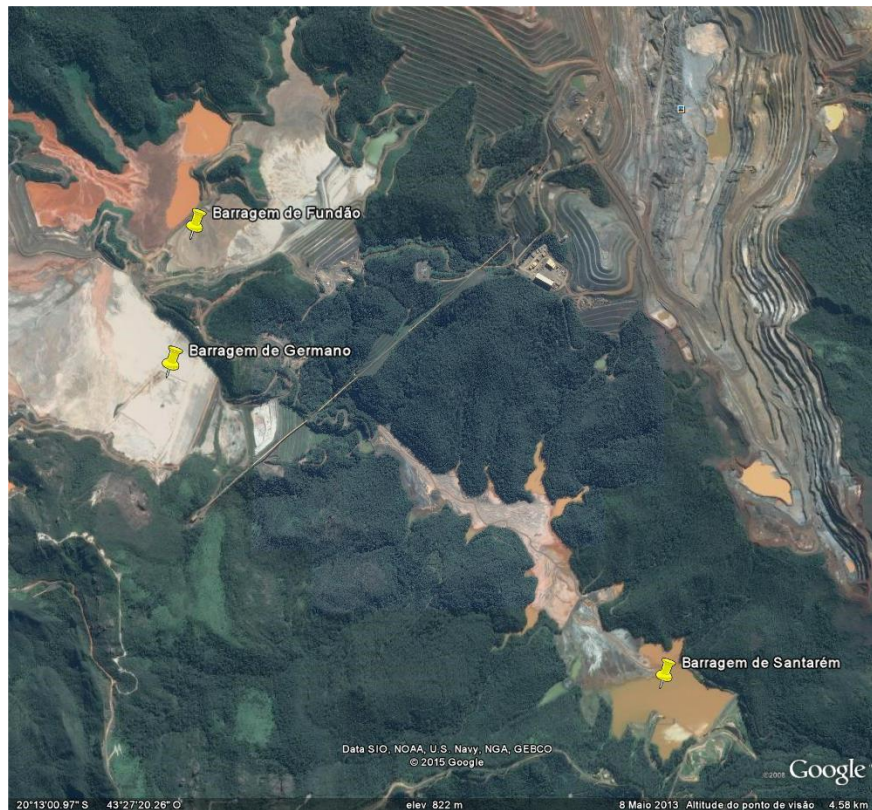
Figura 10 - Barragens do complexo minerário de Germano em Mariana/MG antes do rompimento (2015)
