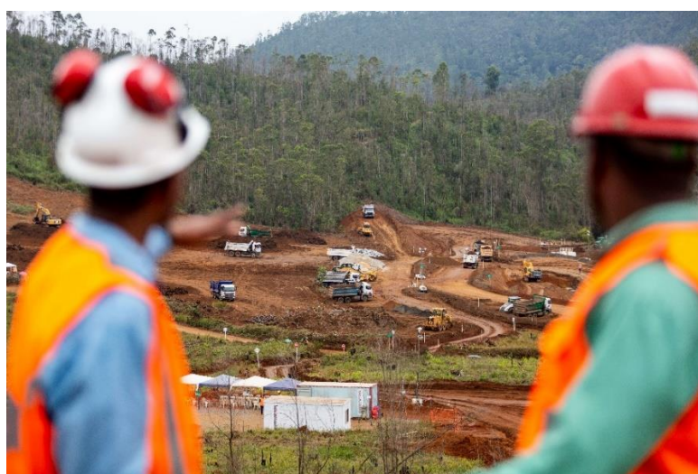
Figura 53 – Terraplanagem no Novo Bento Rodrigues
