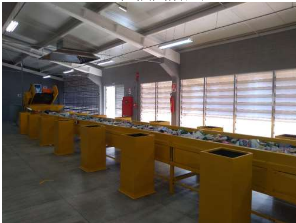
Figura 20- Esteiras de triagem no Galpão sede da Instalação de Recuperação de Resíduos – IRR no Distrito Federal/DF.
