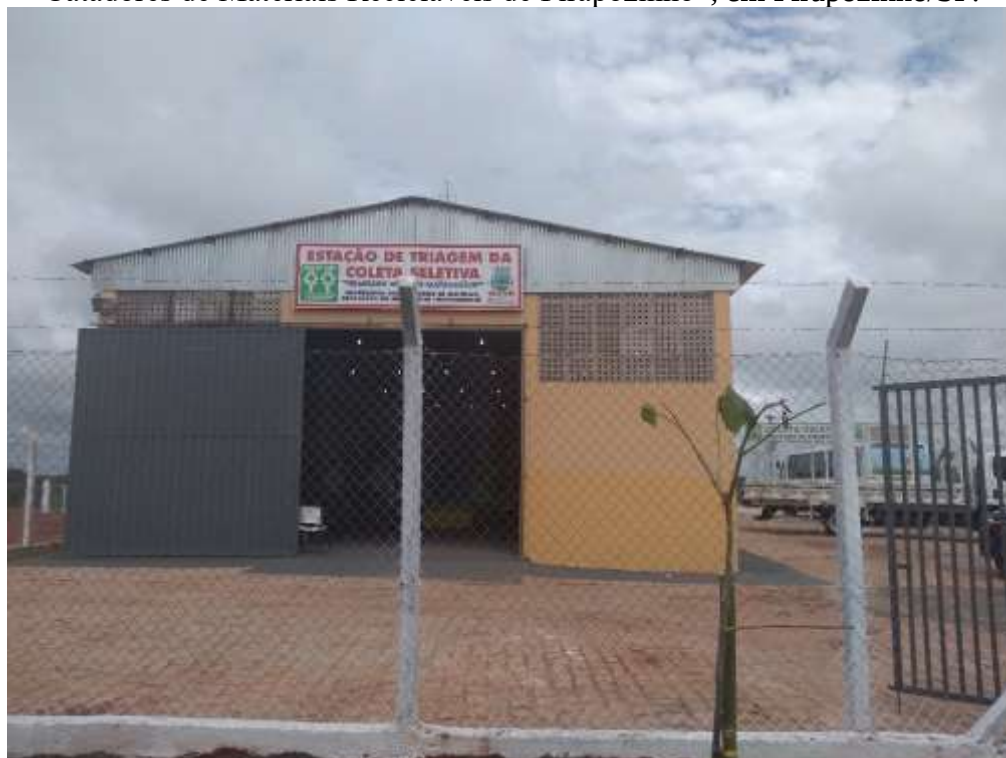
Figura 28 - Fachada do Barracão da “Cidade Joia – Cooperativa de Trabalho de Produção dos Catadores de Materiais Recicláveis de Pirapozinho”, em Pirapozinho/SP.
