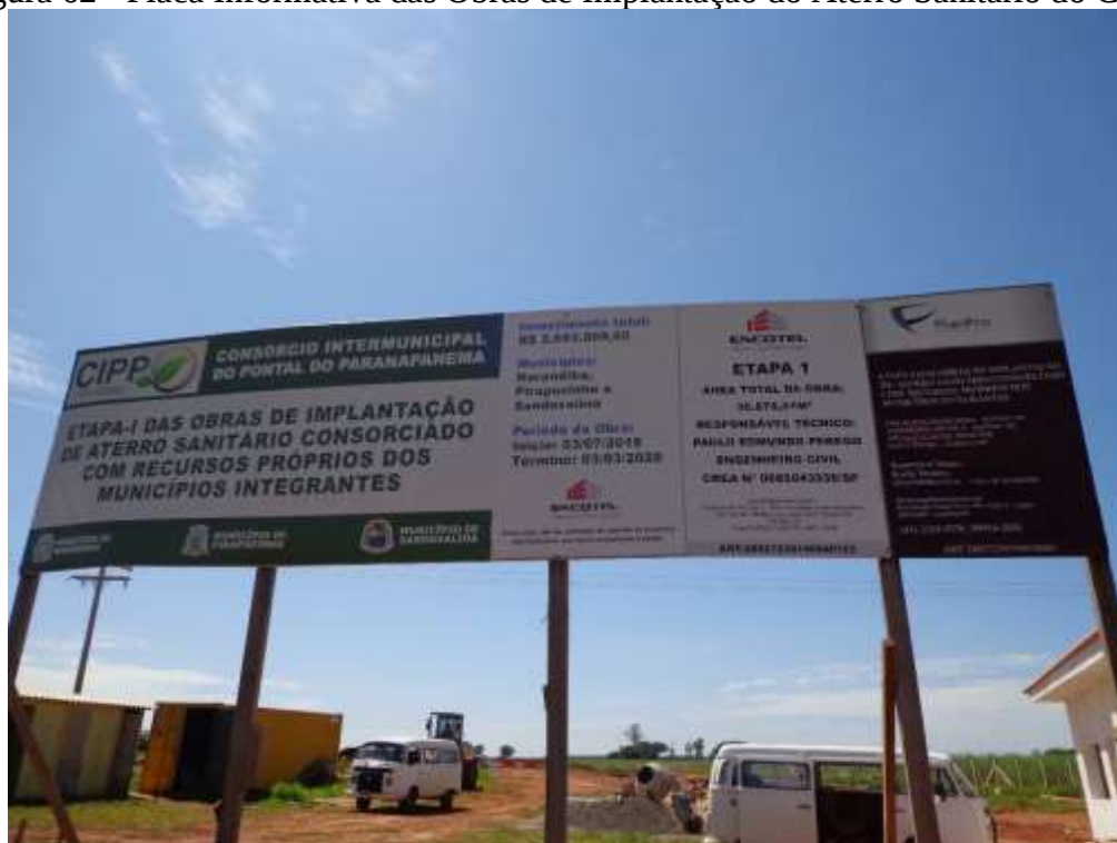
Figura 62 - Placa Informativa das Obras de Implantação do Aterro Sanitário do CIPP.
