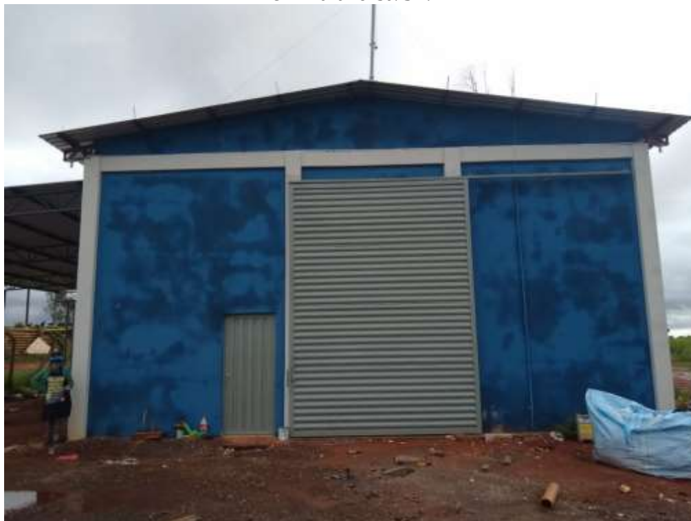
Figura 49 - Fachada do Barracão da “Associação dos Protetores da Natureza – APRONAT”, em Narandiba/SP.
