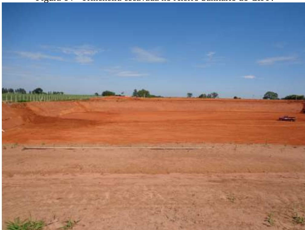
Figura 64 - Trincheira escavada no Aterro Sanitário do CIPP.
