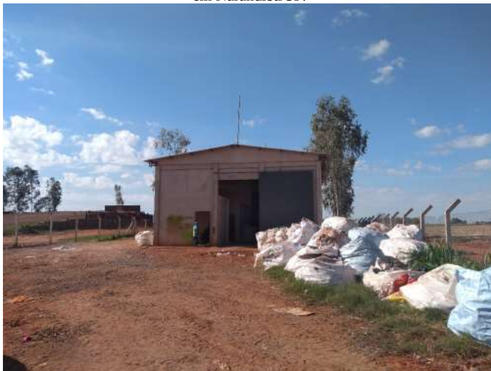
Figura 47 - Fachada do Barracão da “Associação dos Protetores da Natureza – APRONAT”, em Narandiba/SP.
