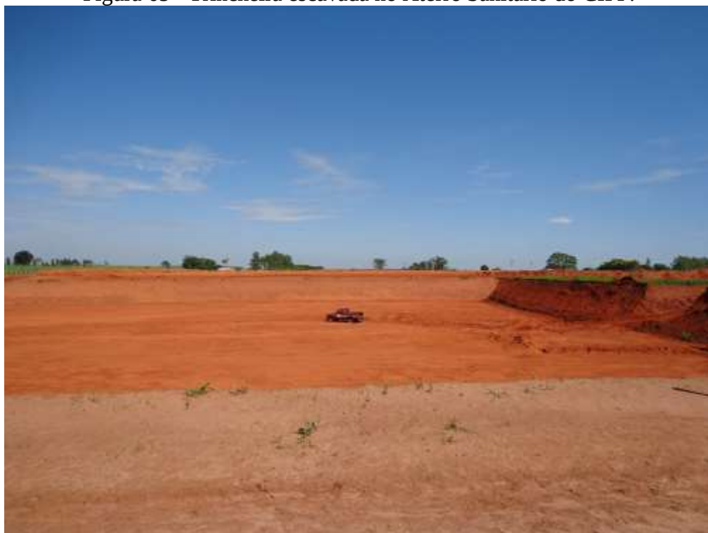
Figura 65 - Trincheira escavada no Aterro Sanitário do CIPP.
