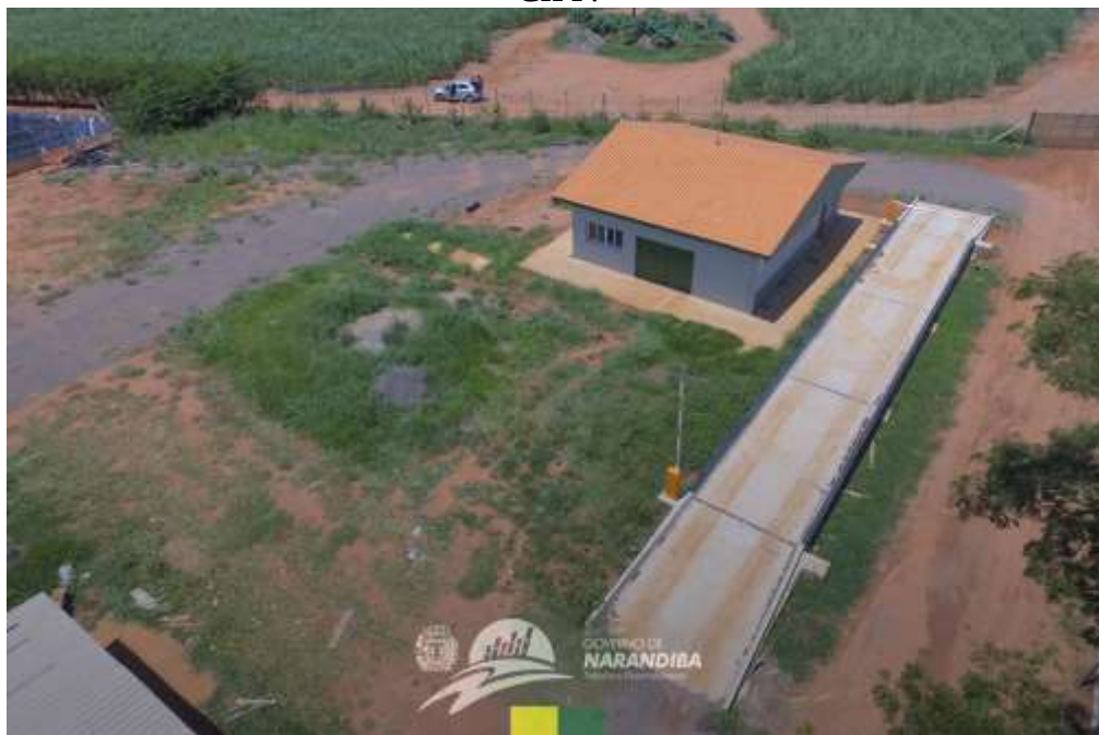
Figura 61 – Vista do Prédio Administrativo e da Balança Rodoviária do Aterro Sanitário do CIPP.
