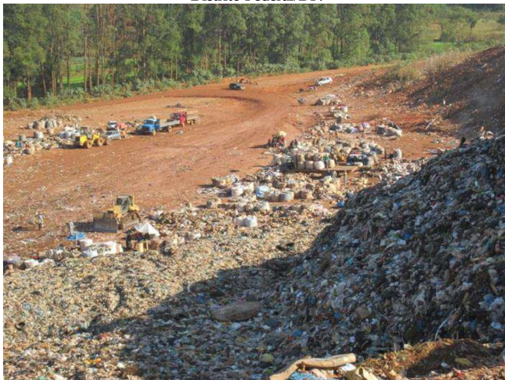
Figura 4 - Frente de descarga de resíduos na área do Aterro Controlado do Jóquei (ACJ) no Distrito Federal/DF.
