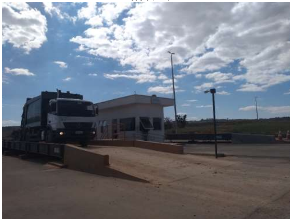
Figura 10 - Balança para pesagem dos caminhões no Aterro Sanitário de Brasília, no Distrito Federal/DF.
