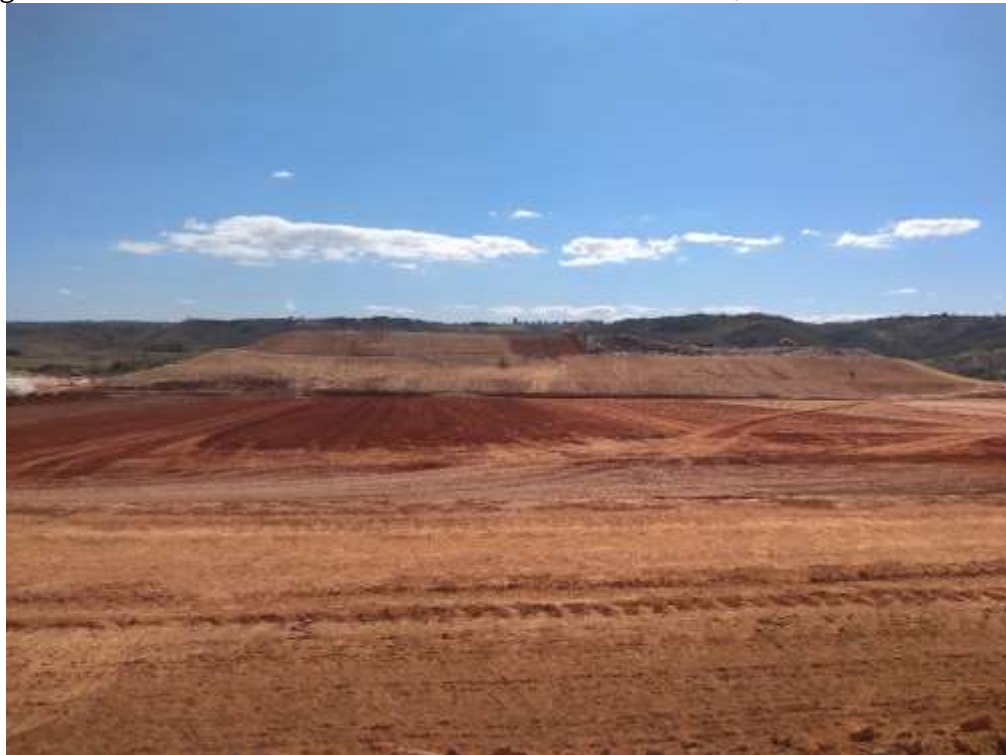
Figura 7 - Vista Panorâmica do Aterro Sanitário de Brasília, no Distrito Federal/DF.
