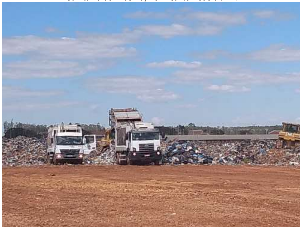
Figura 8 - Descarregamento e Aterramento de Resíduos Sólidos Urbanos e Rejeitos no Aterro Sanitário de Brasília, no Distrito Federal/DF.
