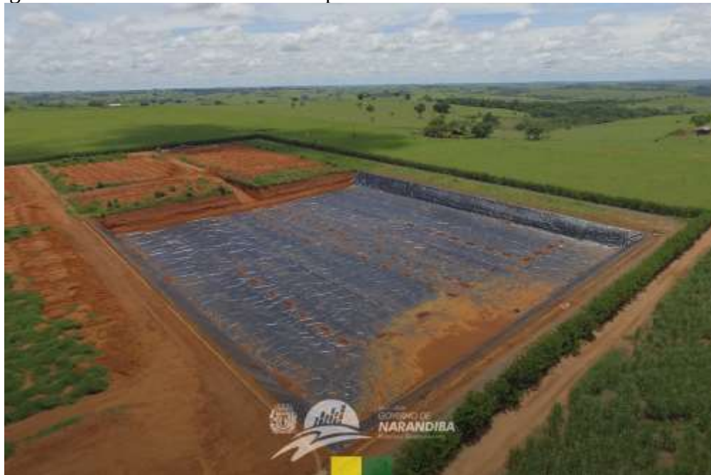
Figura 66 - Trincheira escavada e impermeabilizada no Aterro Sanitário do CIPP.
