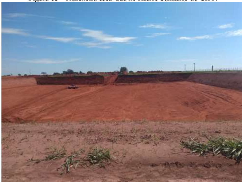
Figura 63 - Trincheira escavada no Aterro Sanitário do CIPP.
