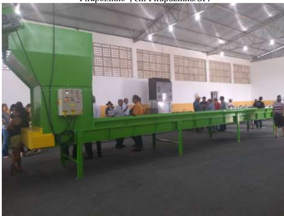
Figura 33 - Funil de Acoplamento e Esteira de Separação de Resíduos da “Cidade Joia – Cooperativa de Trabalho de Produção dos Catadores de Materiais Recicláveis de Pirapozinho”, em Pirapozinho/SP.
