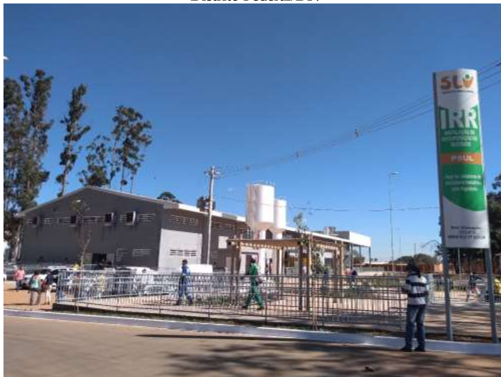
Figura 17 - Fachada do Galpão sede da Instalação de Recuperação de Resíduos – IRR no Distrito Federal/DF.
