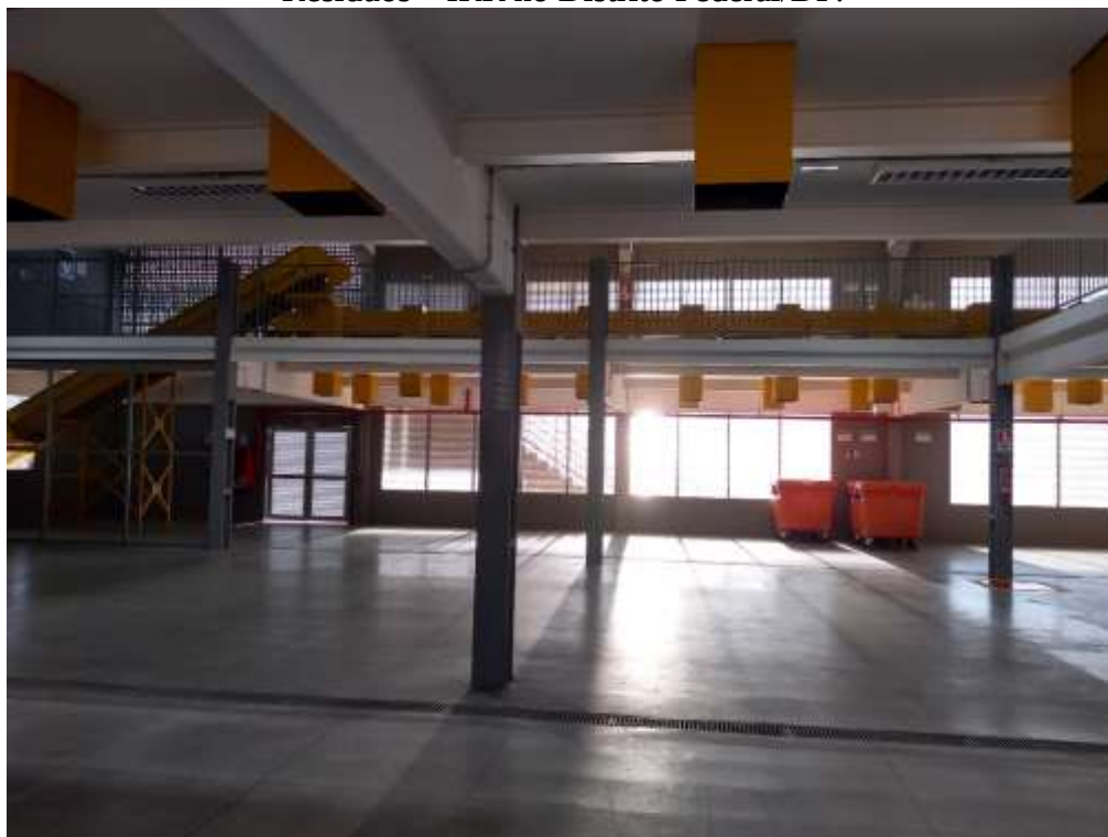
Figura 19 - Esteiras de elevação e de triagem no Galpão sede da Instalação de Recuperação de Resíduos – IRR no Distrito Federal/DF.
