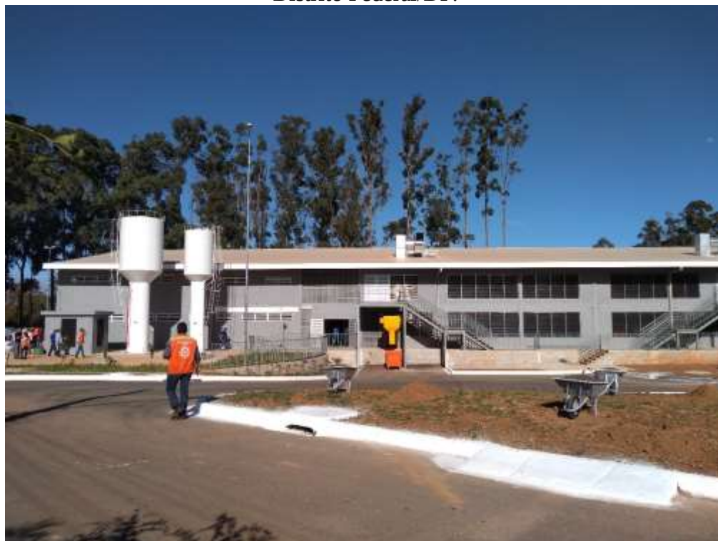
Figura 18 - Lateral do Galpão sede da Instalação de Recuperação de Resíduos – IRR no Distrito Federal/DF.
