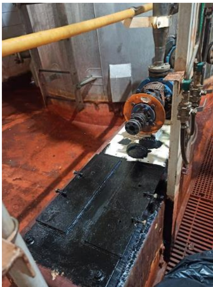
Figura 10 - Base de bomba durante o tratamento
