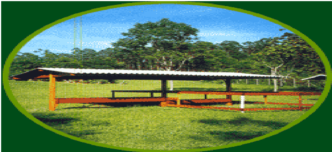
Foto 2 – Creep-feeding construído em madeiramento.
