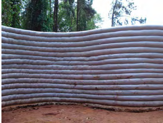
Figura 1: parede de super adobe. Fonte: ( http://www.ecocasa.com.br/produtos.asp?it=849651 )
