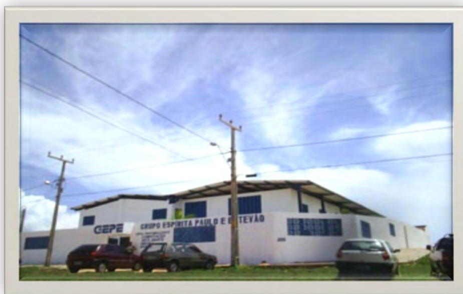
FIGURA 13 - Sede do GEPE- Praia do Futuro FONTE - Portal do GEPE, 2011
