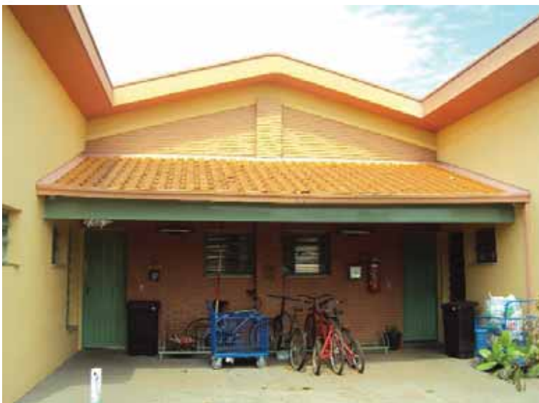
Figura 16: Entrada das residências 2C E 2D da moradia do IBILCE. Fonte: FERRO, 2010.
