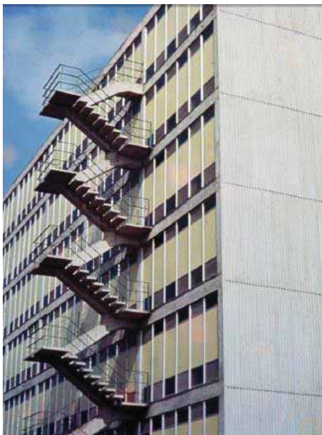
Figura 07: Escadas de emergência dos blocos do Crusp. Fonte: PERRONE;REGINO, 2009
