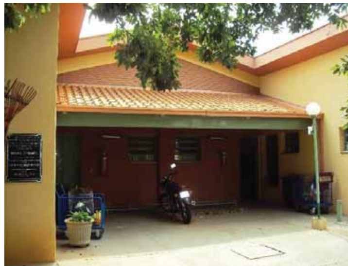
Figura 13: Entrada das Residências 1A e 1B da moradia do IBILCE. Fonte: FERRO, 2010.
