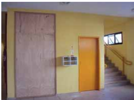
Figura 24: Caixa de escada e elevador do novo bloco da USP. Fonte: FERRO, 2010.
