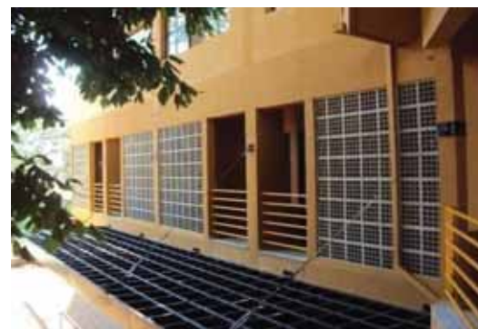
Figura 23: Sacadas do novo bloco da USP. Fonte: FERRO, 2010.
