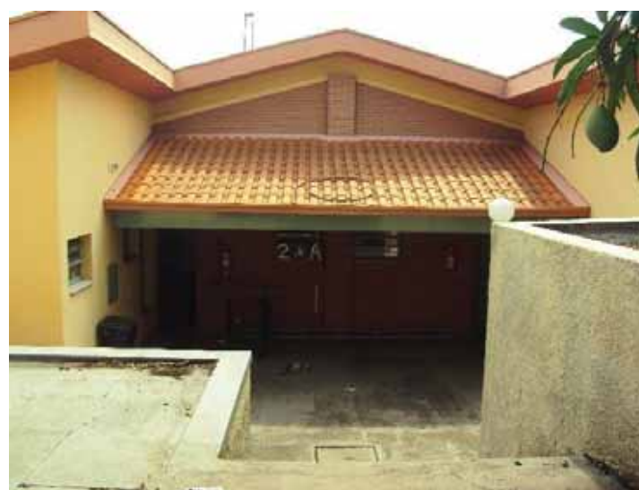
Figura 15: Entrada das residências 2A e 2B da moradia do IBILCE. Fonte: FERRO, 2010.
