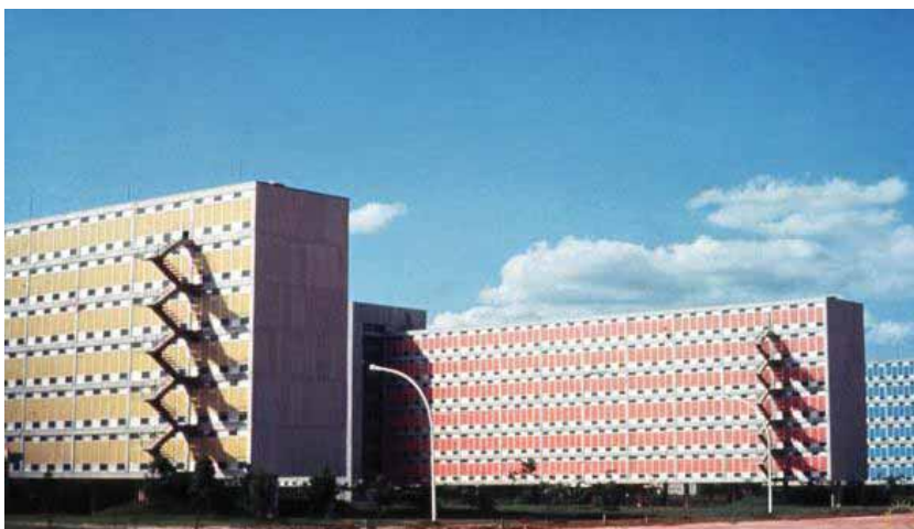
Figura 02: Fachada posterior dos primeiros blocos construídos do Crusp. Fonte: PERRONE;REGINO, 2009
