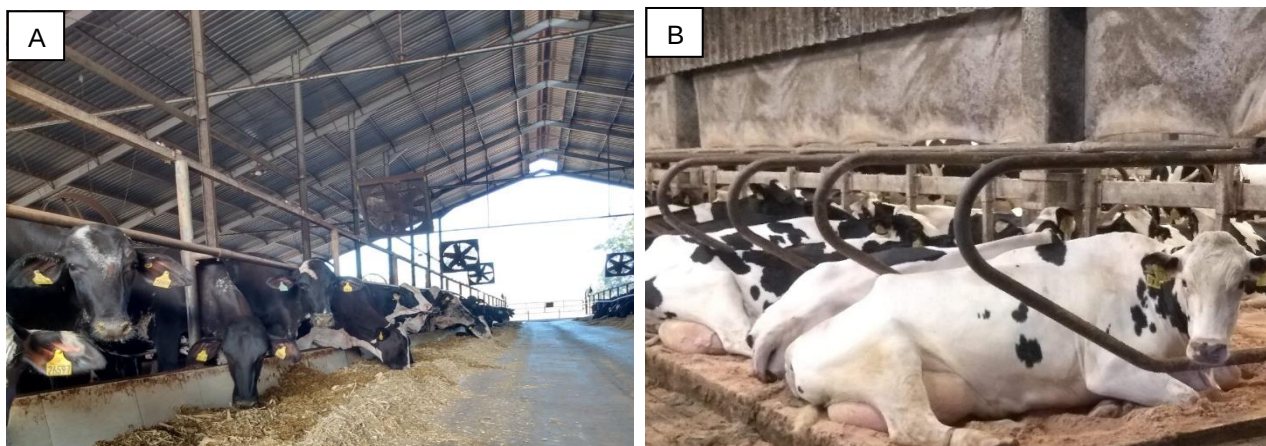
Figura 4 (A; B) - A) Exemplo de instalação com pista de alimentação com sistema de resfriamento por ventiladores; B) Exemplo de instalação com área de descanso com sistema de resfriamento adiabático
