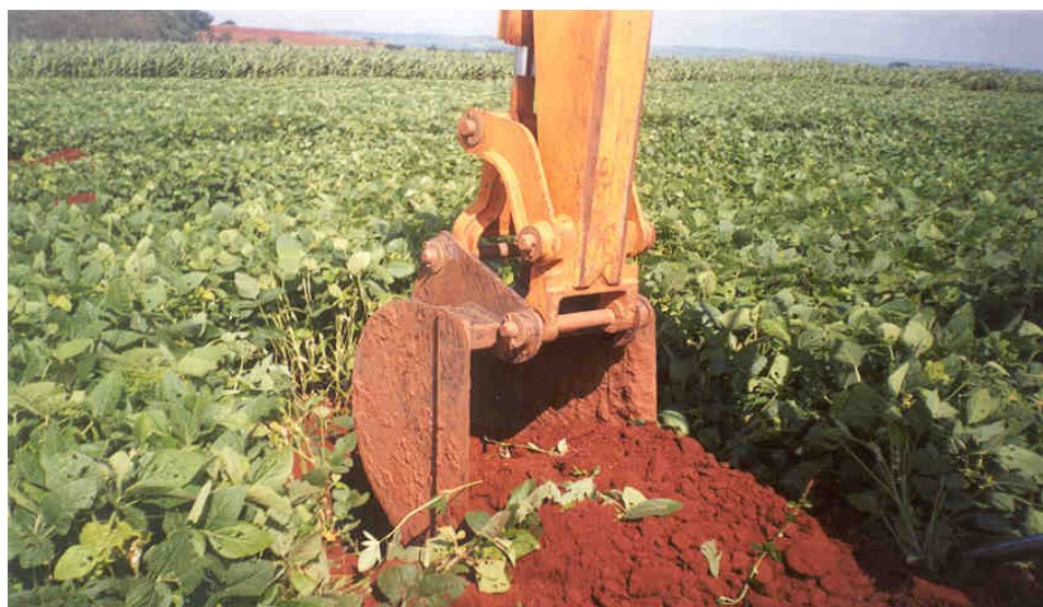
Figura 15 Detalhe da pá da retroescavadeira na abertura das trincheiras.
