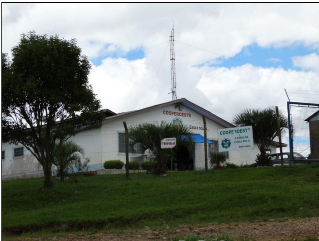
Figura 13 – Primeira sede da Cooperoeste no Assentamento de Reforma Agrária de Barra Bonita, Município de Abelardo Luz-SC.
