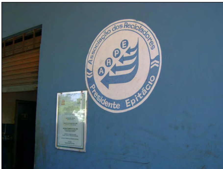
Foto 12: Fachada do barracão onde ficam as instalações da ARPE – Associação dos Recicladores de Presidente Epitácio no aterro controlado
