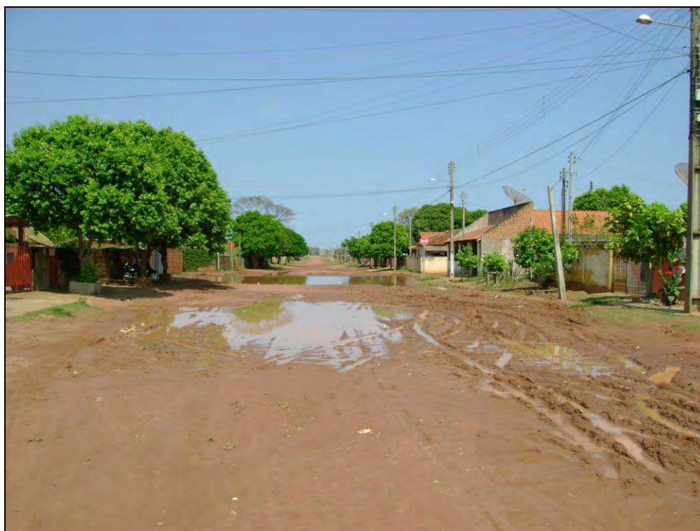
Foto 18: Alagamento em uma rua sem asfalto após a chuva em um bairro de Presidente Epitácio
