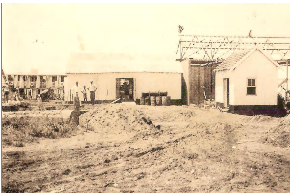
Foto 3: Armazém do Serviço de Navegação da Bacia do Prata na Vila Tibiriçá, década de 40
