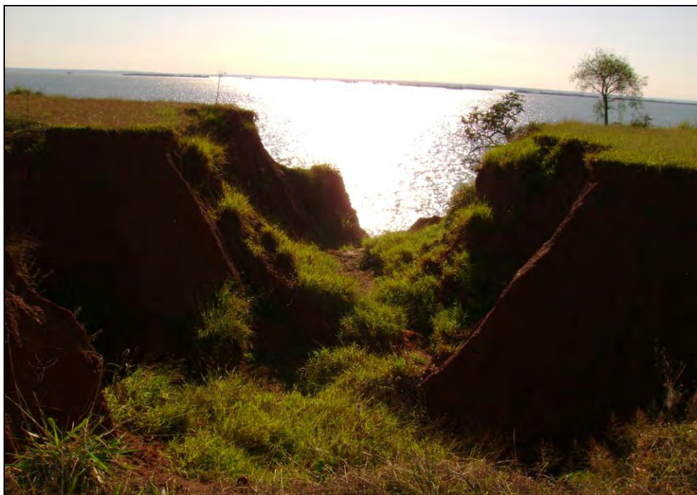
Foto 33: Voçoroca às margens do rio Paraná próximo do Vilage Lagoinha, uma área residencial
