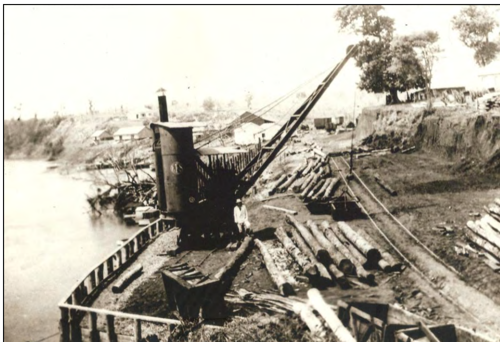
Foto 5: Primeiro guindaste instalado pela Estrada de Ferro Sorocabana no antigo cais de Presidente Epitácio, 1943
