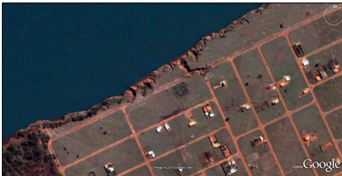
Figura 76 – Processos erosivos avançando em direção ao residencial Village Lagoinha Fonte: Google Earth, 2009
