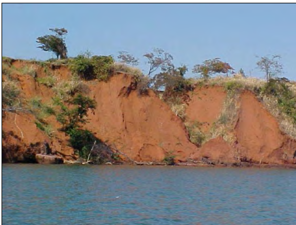
Foto 34: Instabilidade de encosta às margens do rio Paraná
