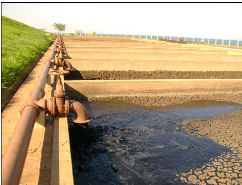
Foto 16: Material sólido resultante da sedimentação do esgoto na lagoa de estabilização
