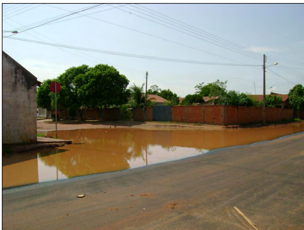
Foto 17: Alagamento de rua após chuvas em um bairro de Presidente Epitácio
