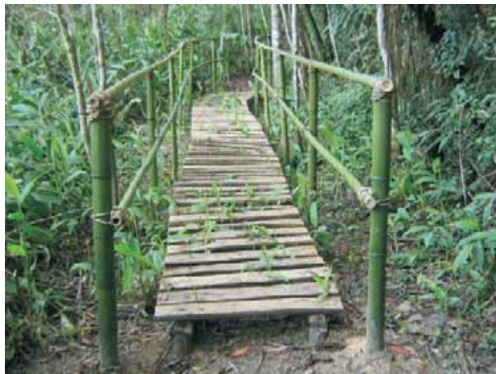
Figura 31: Exemplo de passarela.
