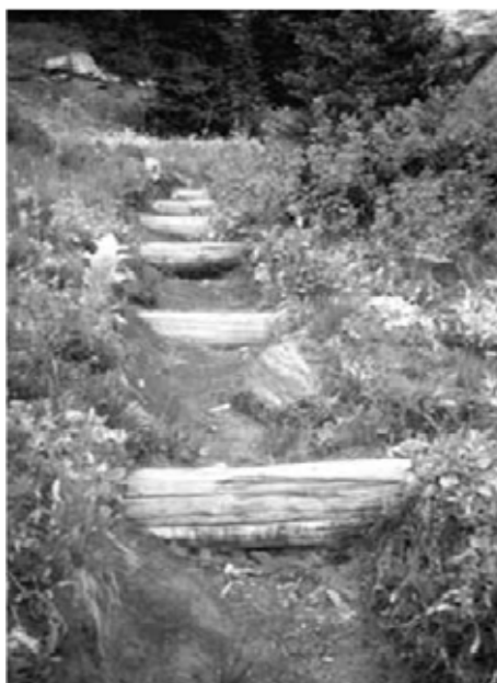
Figura 28: Diques de contenção, depois de alguns anos, esta canaleta deve se recuperar. Fonte: ANDRADE, 2003
