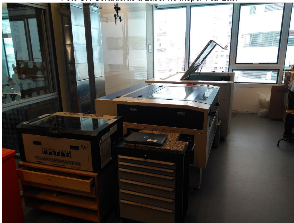
Foto 37. Cortadoras a Laser no Insper Fab Lab.
