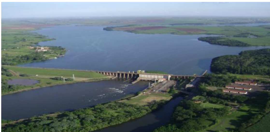
Figura 17 – Usina hidrelétrica e eclusa Bariri
