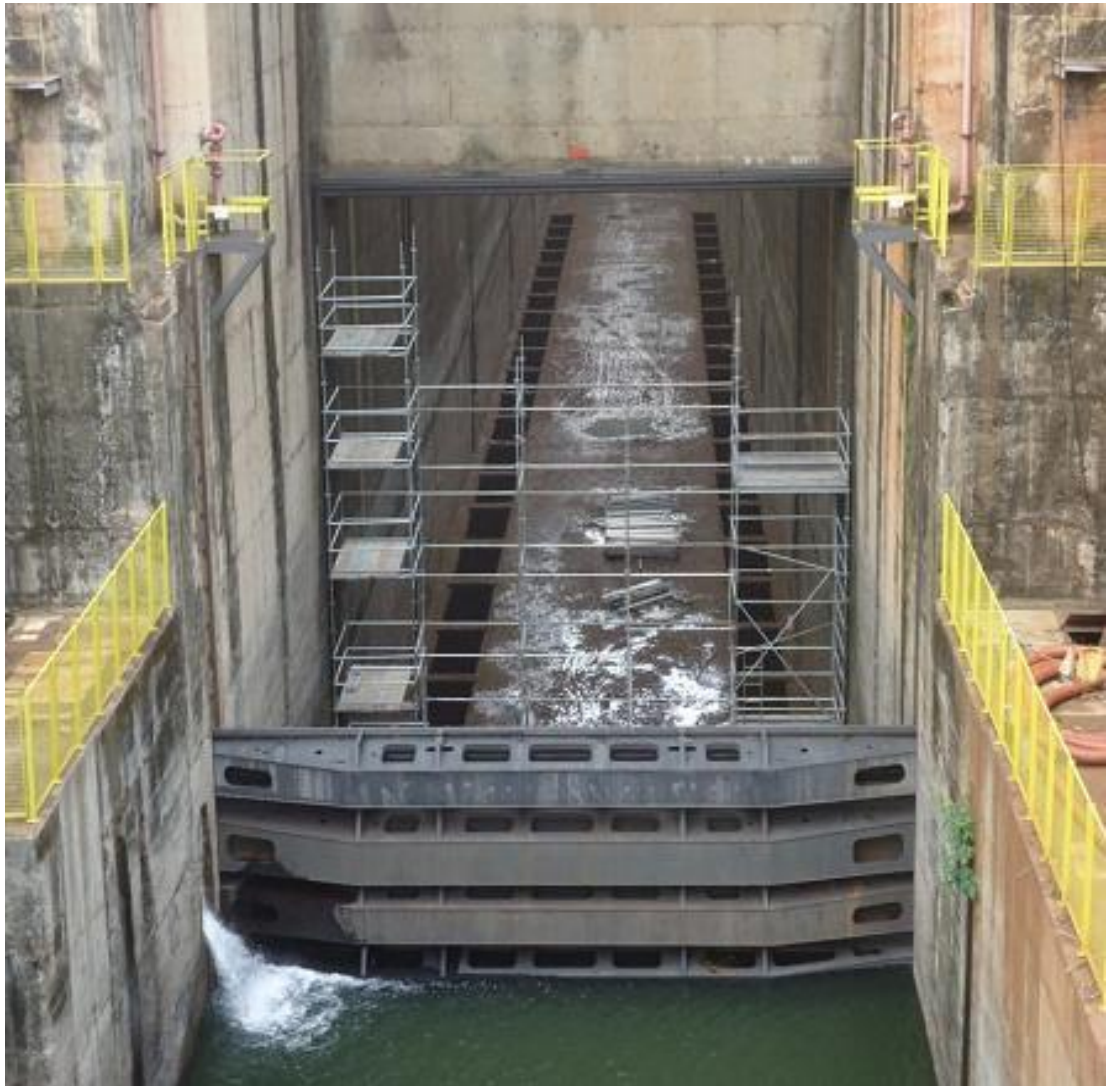
Figura 26 – Manutenção na vedação da porta jusante de uma eclusa
