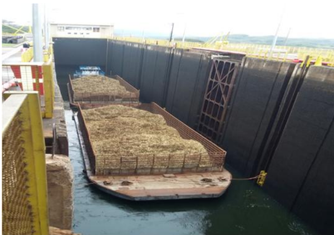
Figura 14 - Comboio carregado no interior da eclusa Bariri
