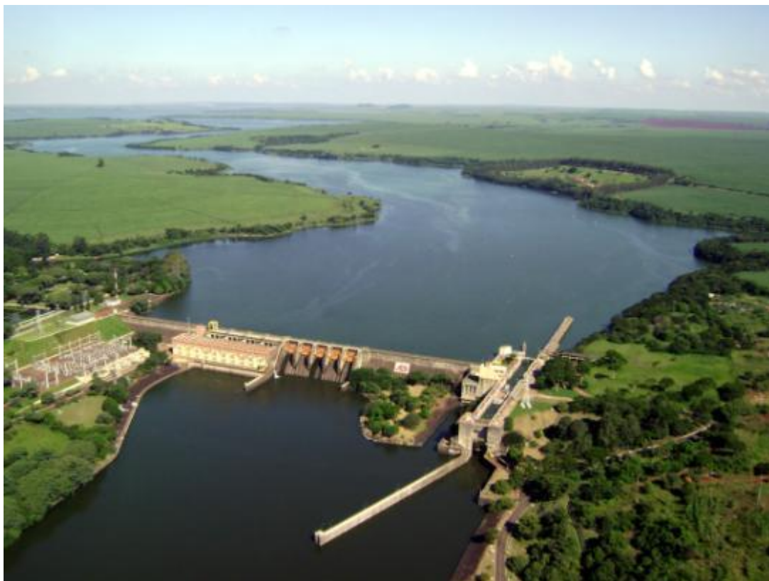
Figura 16 – Usina hidrelétrica e eclusa Barra Bonita
