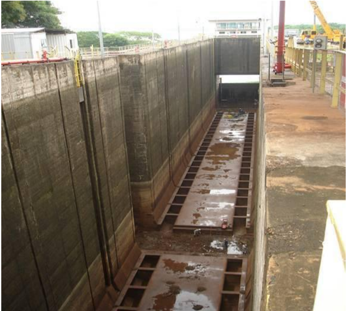
Figura 24 – Manutenção preventiva na câmara da eclusa
