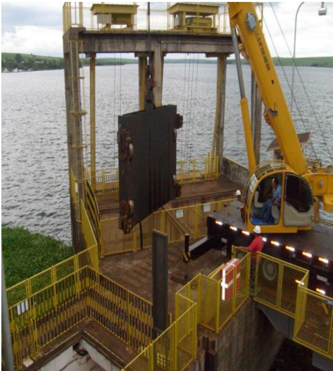
Figura 25 – Comporta do aqueduto de enchimento da eclusa Bariri
