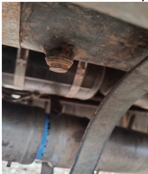
Figura 25: Foto da válvula de dreno de um bujão pneumático.
