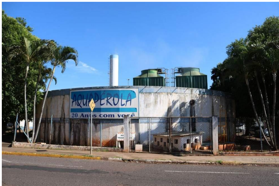
Figura 21: Reservatório do poço Água Pérola (atual)
