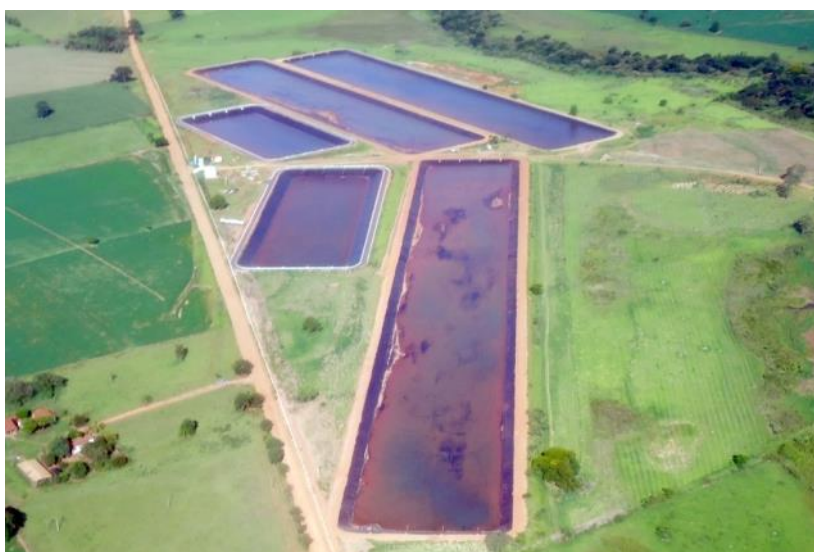
Figura 25: Estação de Tratamento de Esgoto
