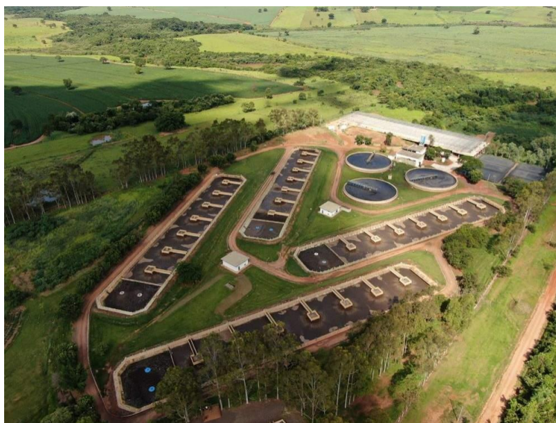
Figura 34: Estação de Tratamento de Esgoto Baguaçu
