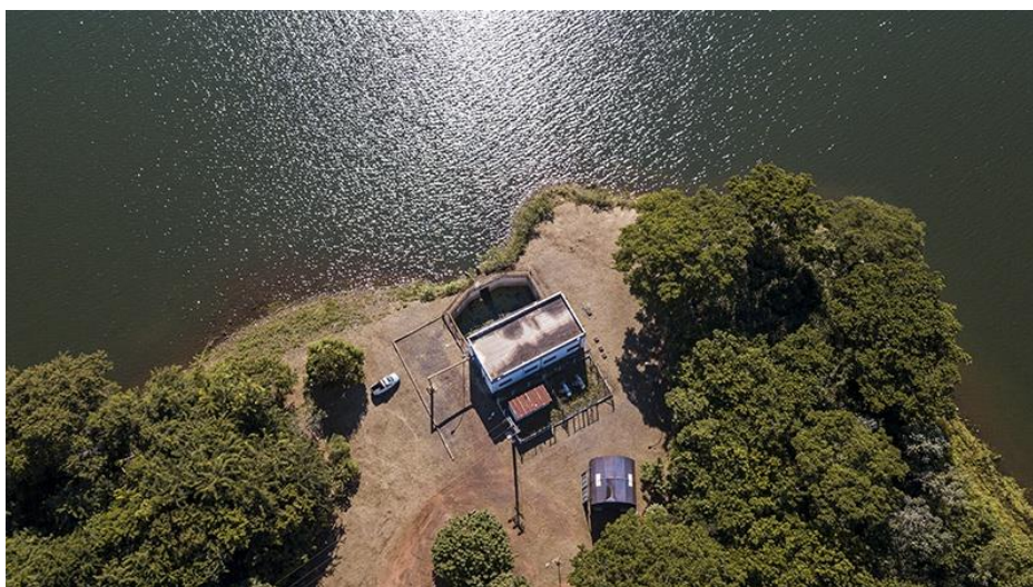
Figura 31: Sistema de Captação no Rio Tietê
