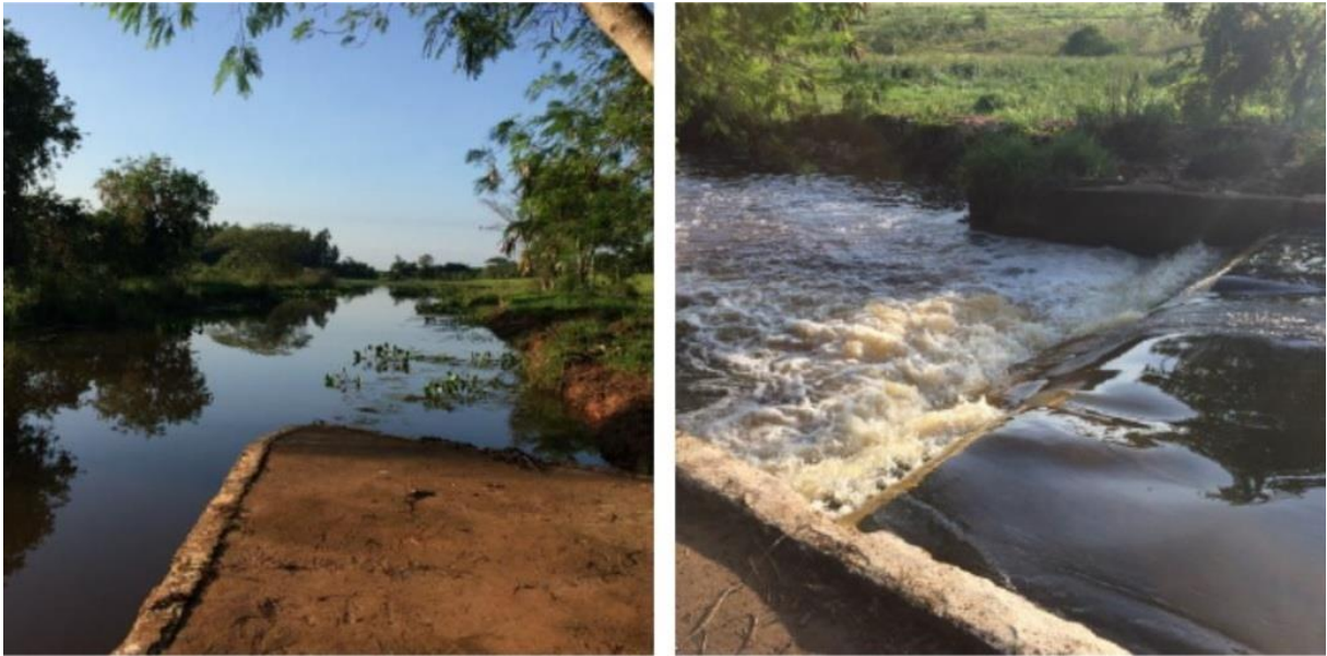
Figura 17: Barragem de Captação no Córrego Baixotes
