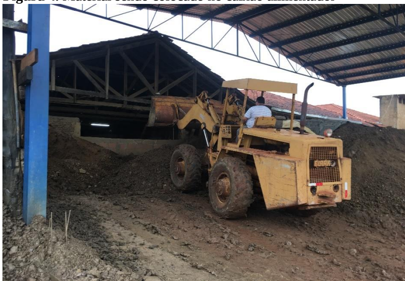
Figura 4. Material sendo colocado no caixão alimentador
