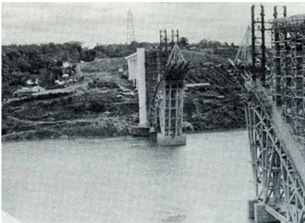
Imagem 8: Construção da Ponte da Amizade.
