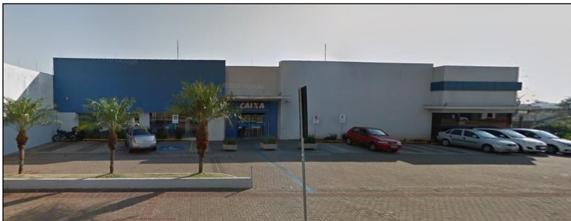
Fotografia 20 – Londrina. Avenida Madre Leônia Milito, Caixa Econômica Federal. 2019
