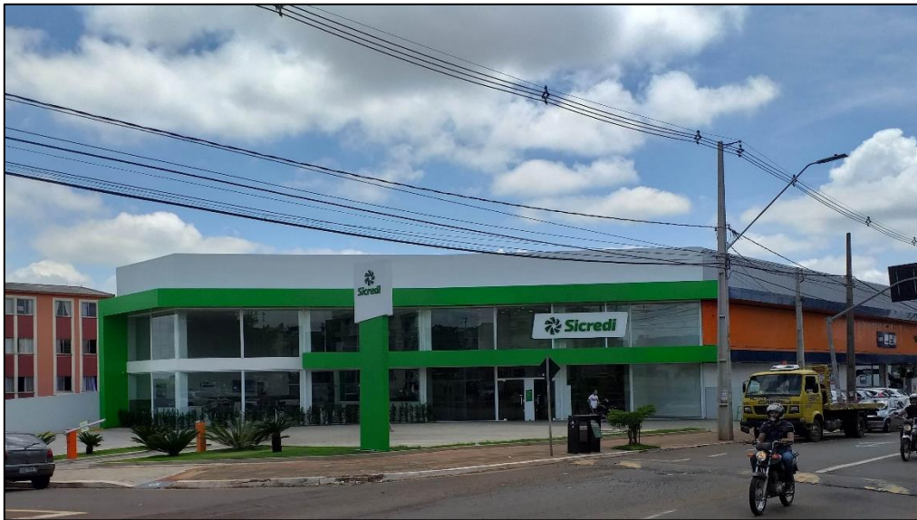
Fotografia 34– Londrina. Avenida Saul Elkind. Banco Sicredi, 2019.
