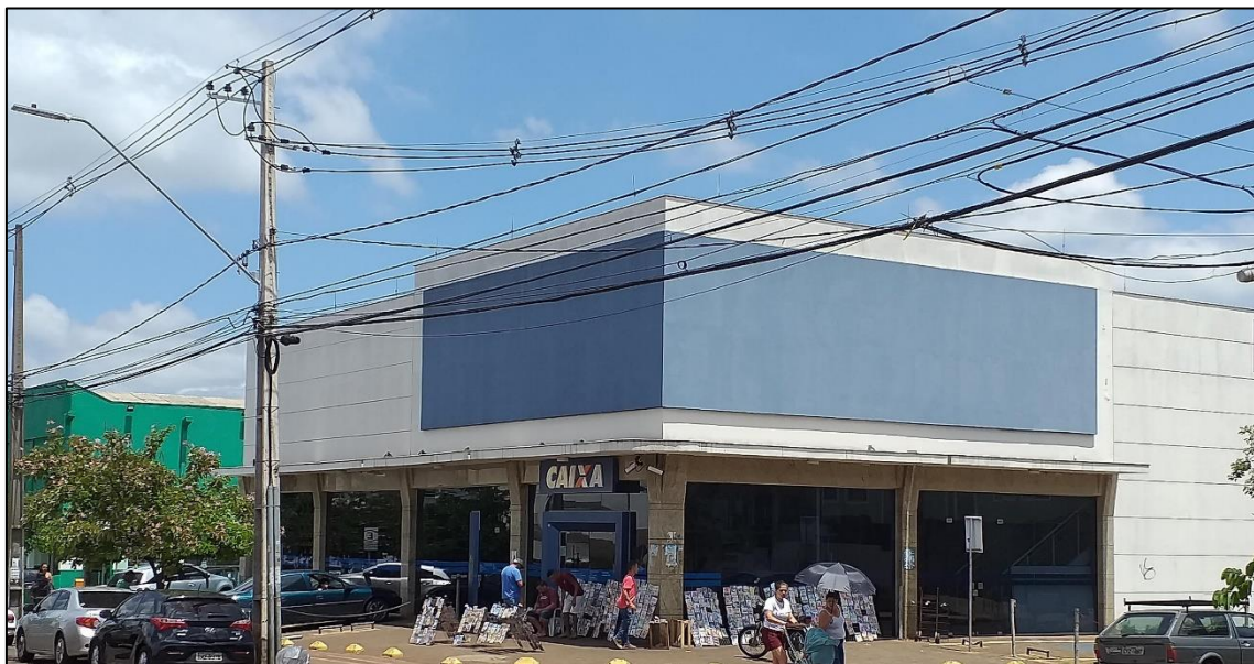
Fotografia 35- Londrina. Avenida Saul Elkind. Caixa Econômica Federal, 2019.
