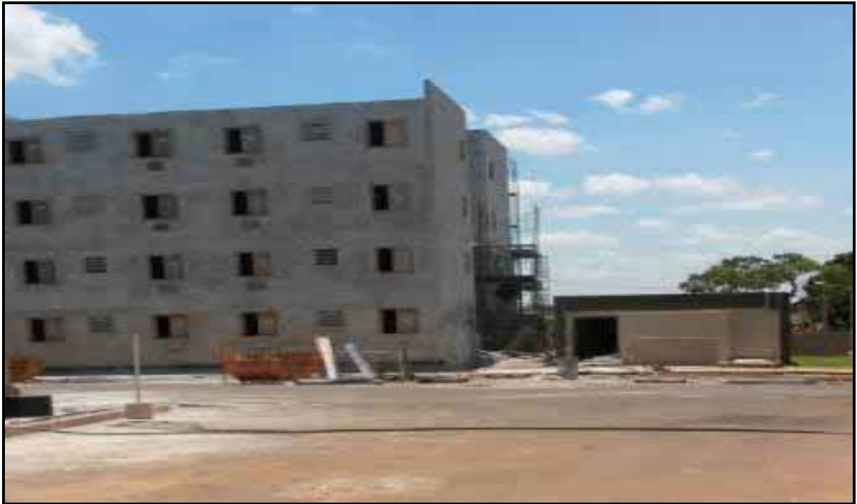
Figura 13–Um dos canteiros de obras da Construtora “B”
