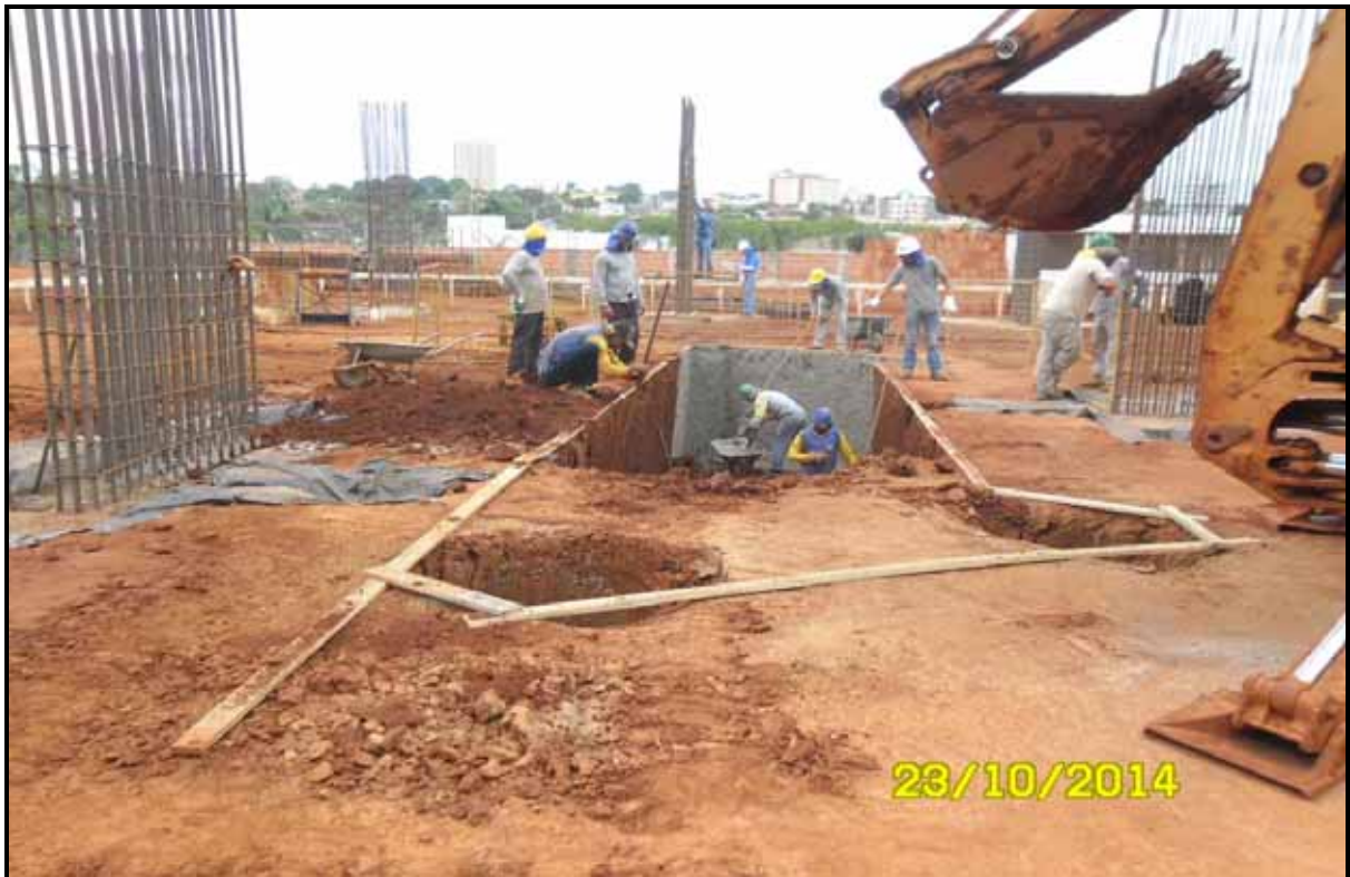
Figura 9 - Trabalho nas fundações do mesmo edifício.
