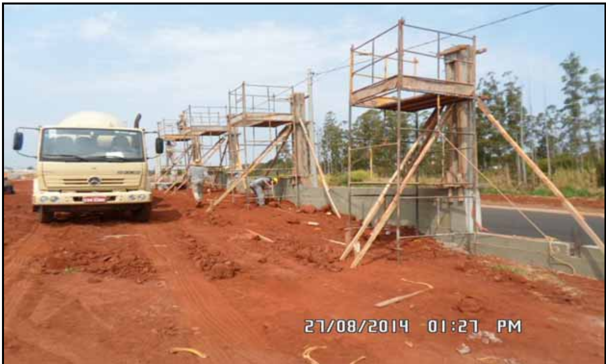
Figura 3 - Construção dos muros do mesmo condomínio, visto na imagem anterior.
