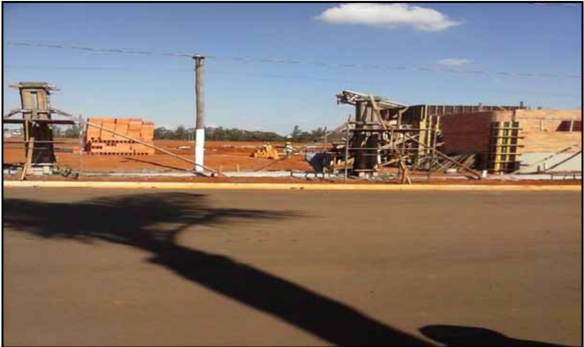
Figura 1 - Início da construção de um condomínio horizontal pela Construtora “A”
