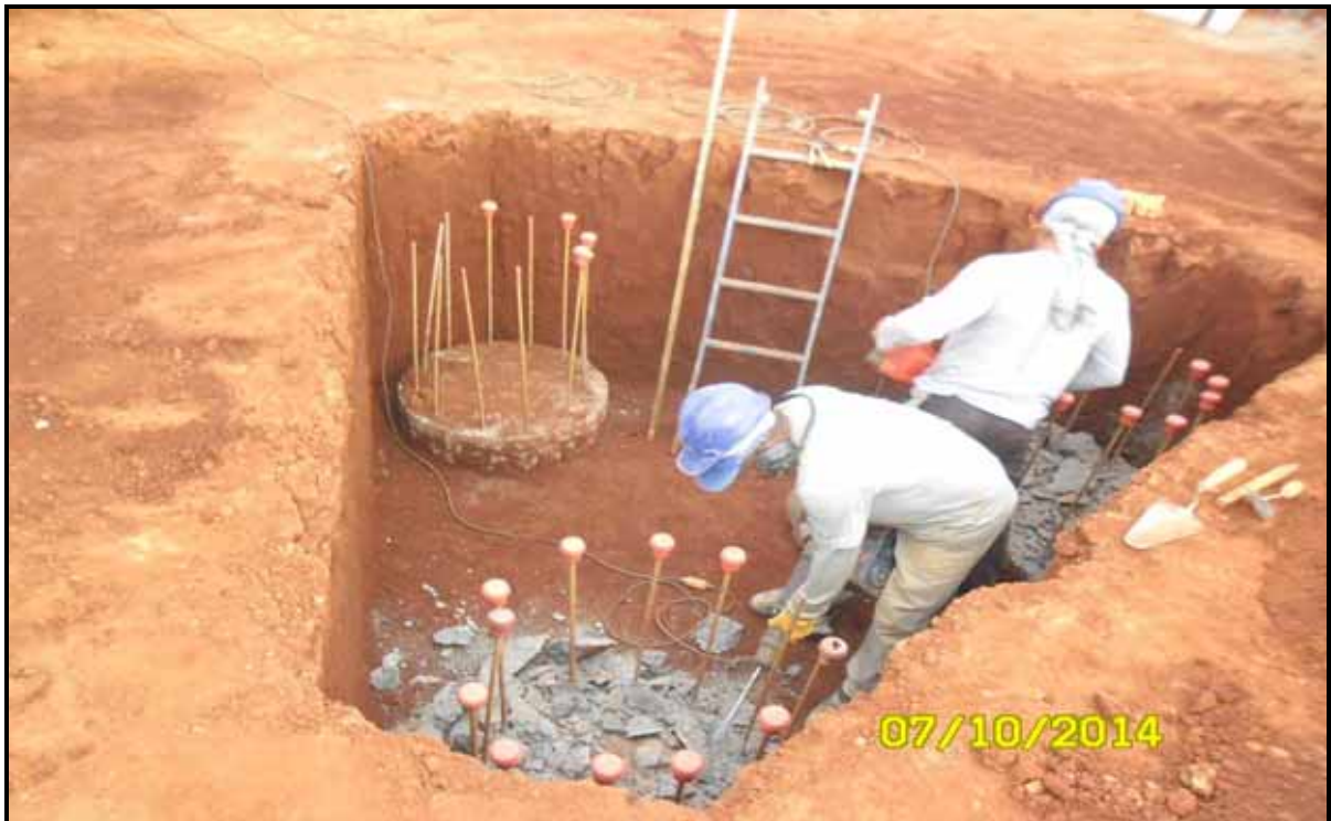
Figura 7 - Fase de fundação de um edifício da Construtora “A”: trabalho dos armadores.
