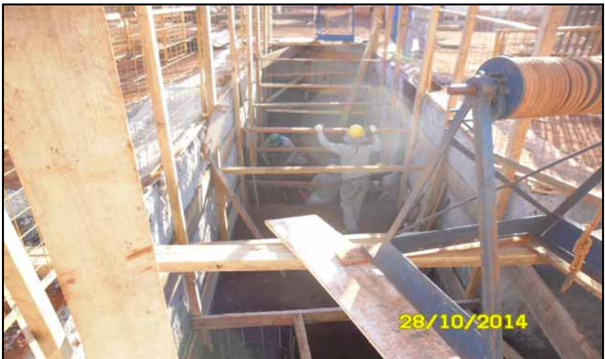
Figura 10 - Trabalho dos carpinteiros nas fundações do mesmo edifício.
