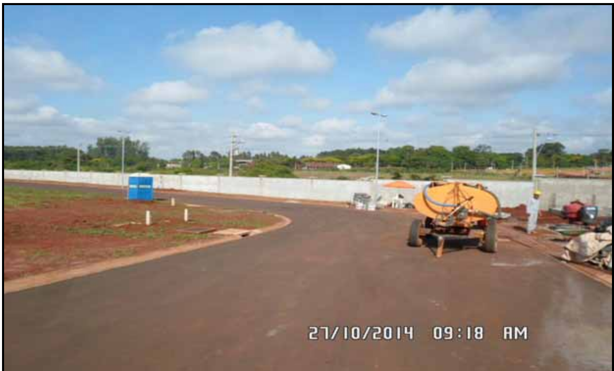
Figura 4 - Término da construção dos muros deste condomínio
