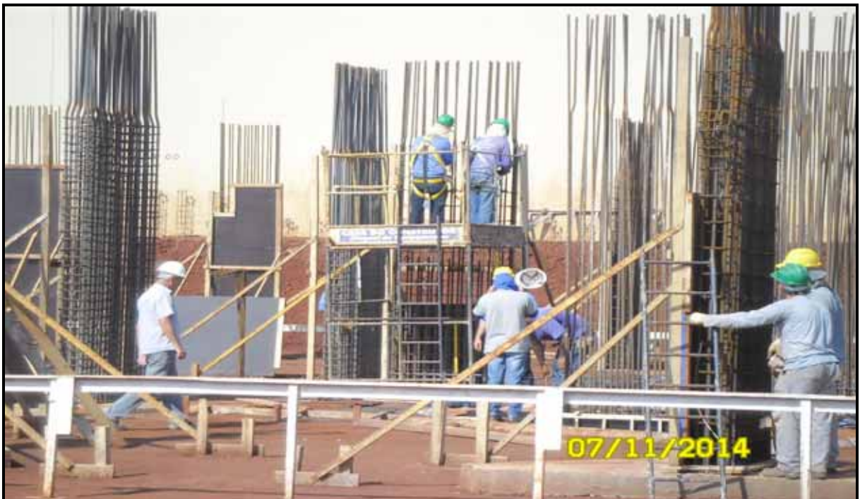
Figura 12 - Armação da estrutura de ferro do mesmo edifício
