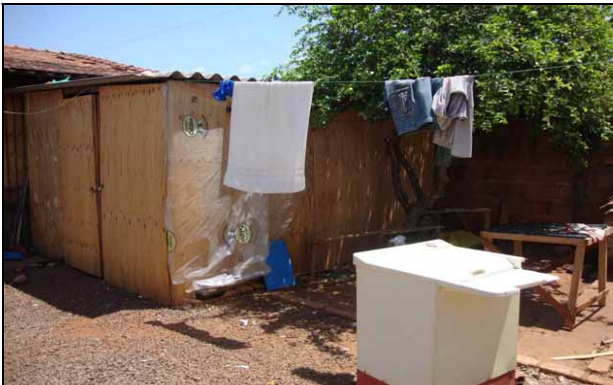
Figura 21 - Varanda fechada com tapumes, transformada em quarto, sem nenhuma ventilação.
