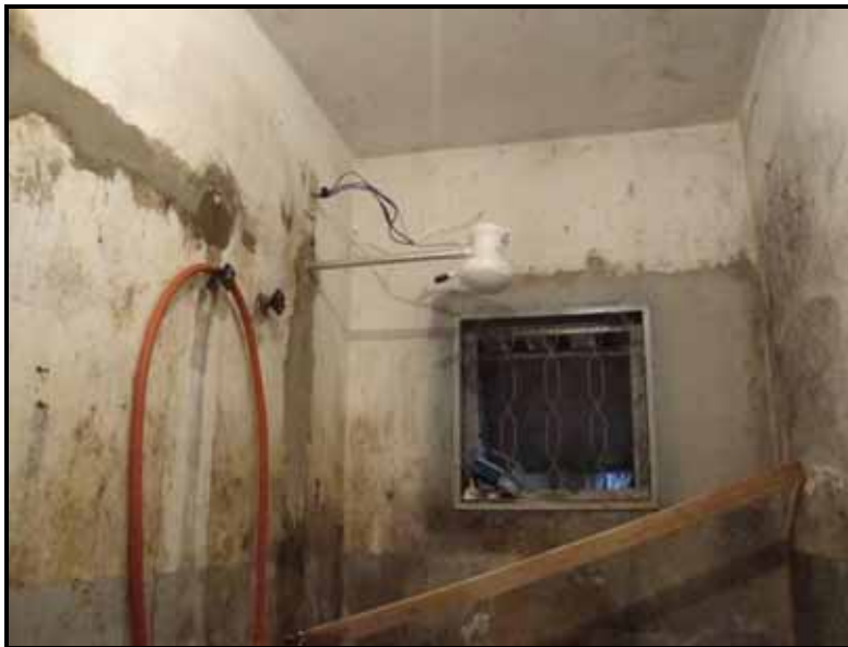
Figura 22 - Banheiro do alojamento (1)
