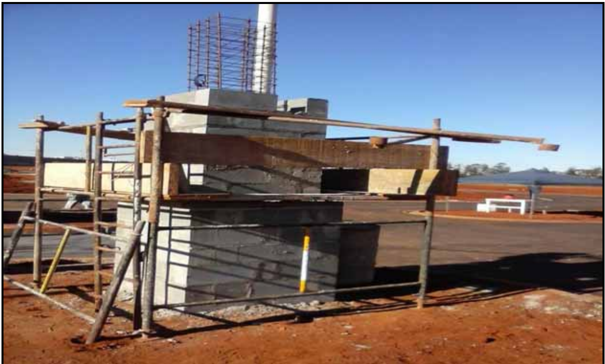
Figura 2 - Construção dos pilares da portaria de entrada do mesmo condomínio visto na imagem anterior.
