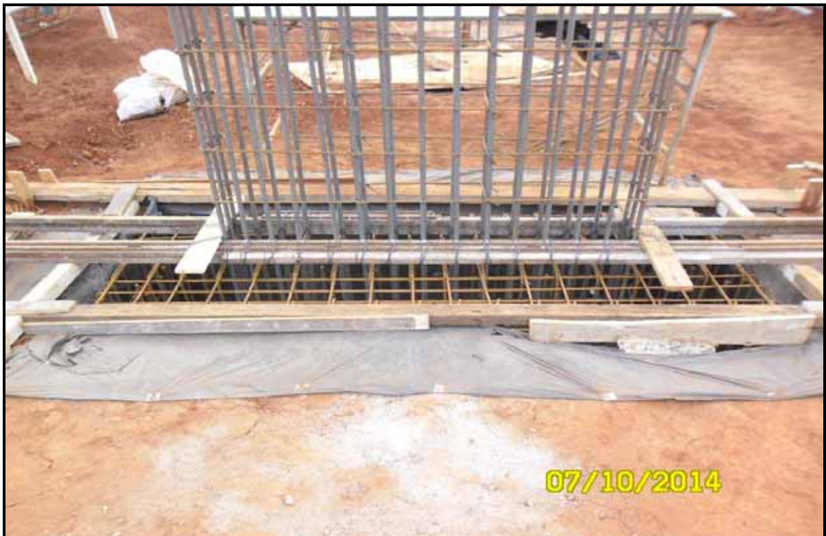
Figura 8 - Armações de ferro usadas nas fundações do mesmo edifício.
