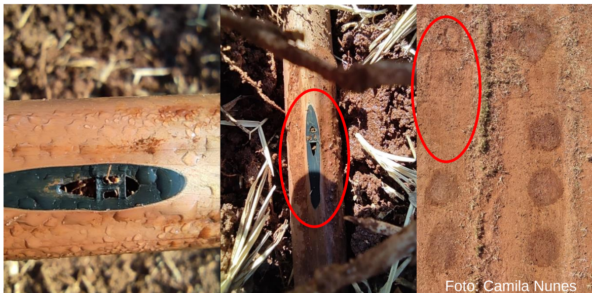
Figura 20 – Entupimento dos gotejadores acarretando má distribuição de água dentro das subparcelas
