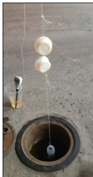
Foto 10 - Dispositivos sendo inseridos dentro do poço de monitoramento
