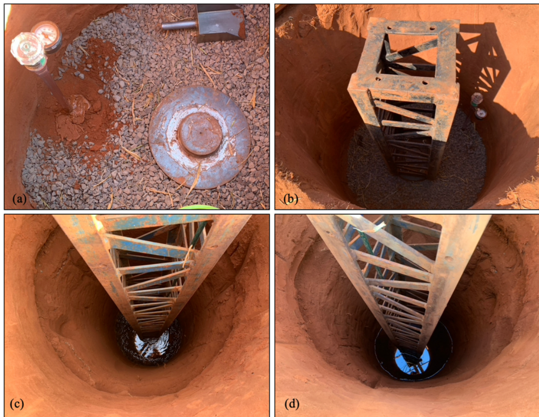
Figura 5.6 – Detalhes gerais do processo de inundação do ensaio PLT: (a) instalação do tensiômetro; (b) montagem da torre e equilíbrio da sucção; (c) início do processo de inundação; (d) processo de inundação em andamento.
