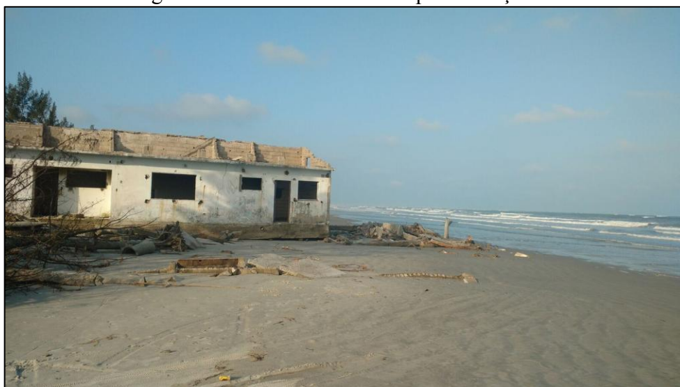
Figura 06: Imóveis Destruídos pelo avanço do mar
