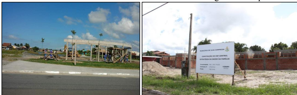
Figura 22: Obras em andamento em Ilha Comprida: Parque da Lagoa da Adriana. Construção da nova UPA e abertura das Avenidas Central e Marginal Candapuí
