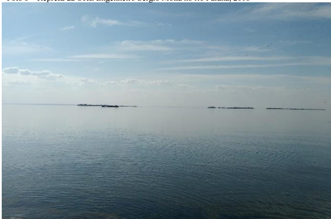
Foto 8 – Represa da UHE Engenheiro Sérgio Motta no rio Paraná, 2018
