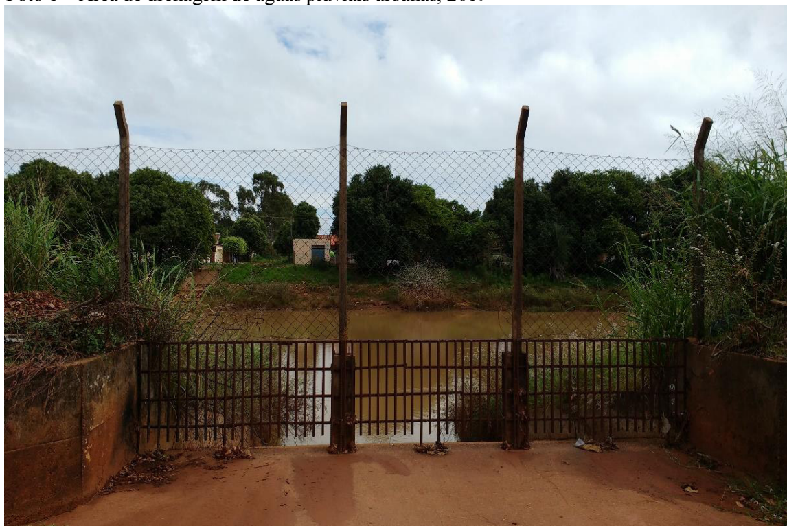
Foto 1 – Área de drenagem de águas pluviais urbanas, 2019
