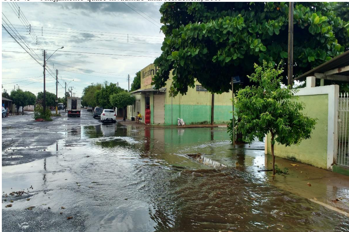
Foto 45 – Alagamento quase invadindo uma residência, 2019
