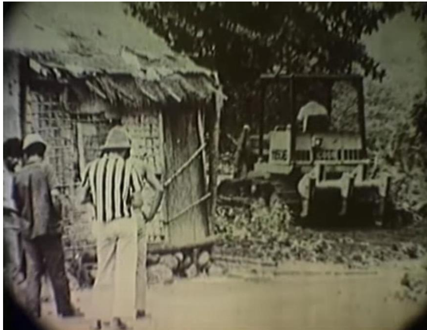
Figura 22: Casa de caiçara sendo derrubada pelo trator da empresa multinacional.
