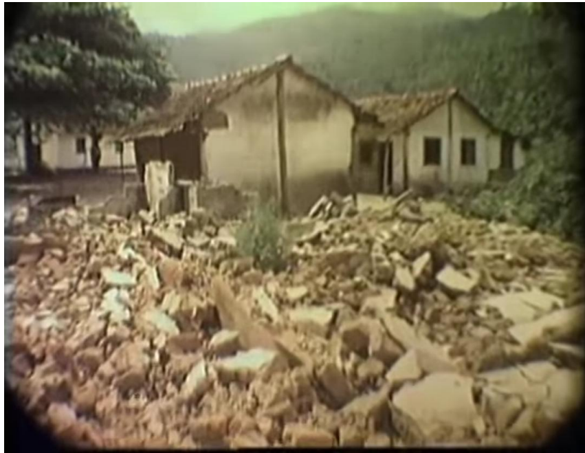
Figura 13: Destruição de casas na Praia do Sono.
