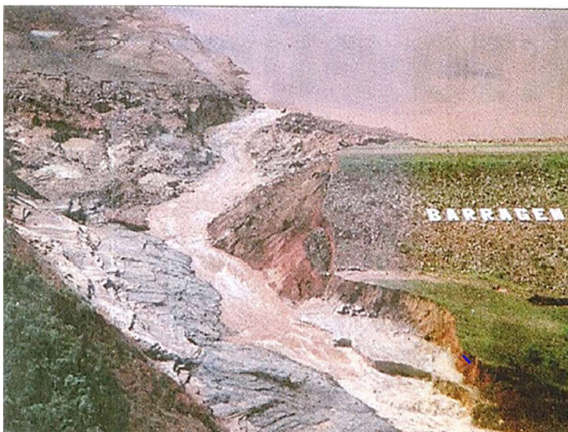
Figura 23 – Queda de toda estrutura de concreto
