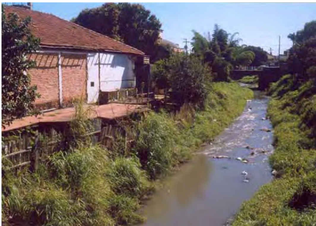
Figura 50. Construções irregulares dentro de A.P.P do Ribeirão Lavapés, no centro da cidade de Botucatu.
