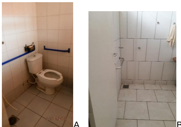
Figuras 40 A e B – Áreas de banhos dos banheiros femininos da ILPI I (A) e II (B).
