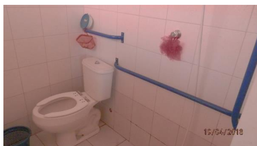
Figuras 38 A e B – Presença de barras de apoios no vaso sanitário e área de banho (A) e portas dos banheiros com larguras adequadas (B).
