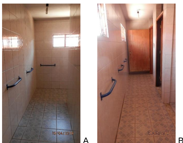
Figuras 53 A e B - Presença de barras de apoio fixadas nas paredes das circulações dos banheiros coletivos do salão comunitário.
