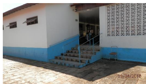
Figuras 90 A e B – As áreas circundas do salão foram consideradas circulações externas (A); ) e escada de acesso ao salão inadequadas (B).
