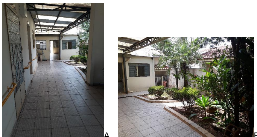
Figuras 91 A e B – Circulação de acesso ao salão comunitário da ILPI II.
