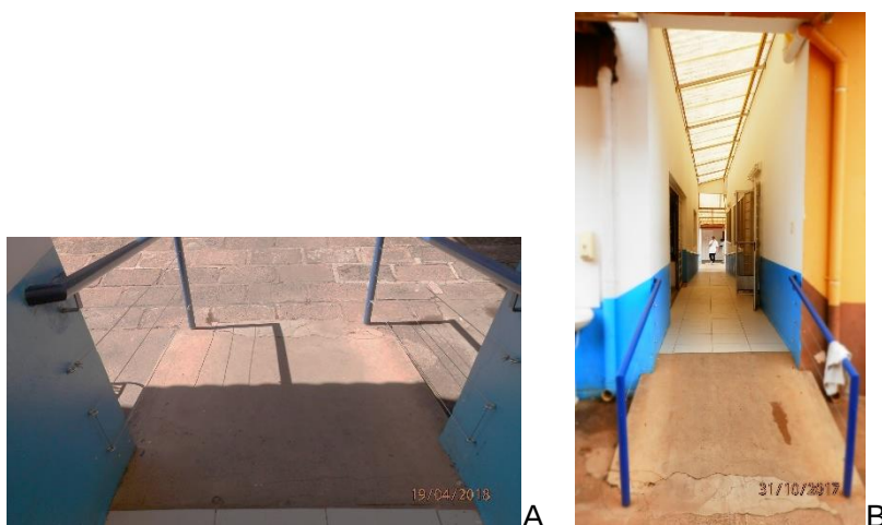
Figuras 83 A e B – Rampas de acesso localizada na circulação de acesso ao refeitório, ILPI I.
