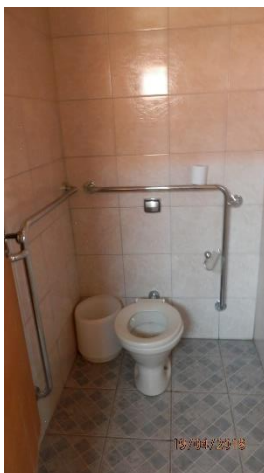
Figura 54 – Os banheiros coletivos são equipados com cabine acessível.
