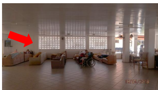
Figuras 51 A e B – Presença de elementos vazados (cobogós) na ILPI 1 (A) e na ILPI 2 há toldos nas aberturas que equilibram a temperatura no local (B).
