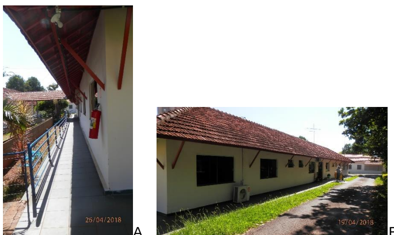
Figuras 64 A e B – Circulação frontal da edificação com presença de guarda-corpo e corrimão (A) e a circulação atrás do edifício (B).
