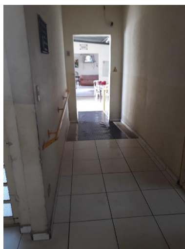
Figura 84 – Circulação de acesso ao refeitório da ILPI II.
